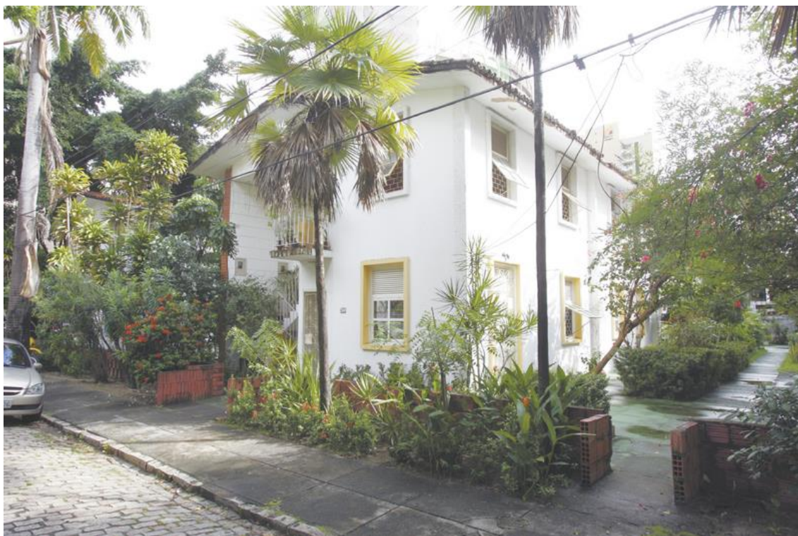
Figura 26 – Residencial Iracema, localizado na Rua Antônio Augusto, nº 185.
