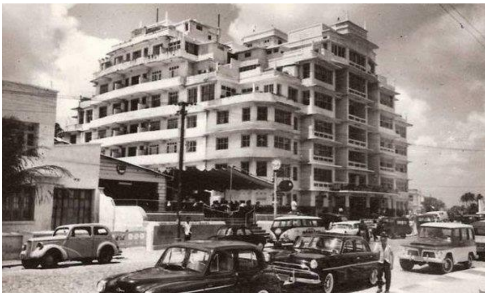
Figura 5 – Edifício São Pedro, antigo Iracema Plaza Hotel, em 1960.
