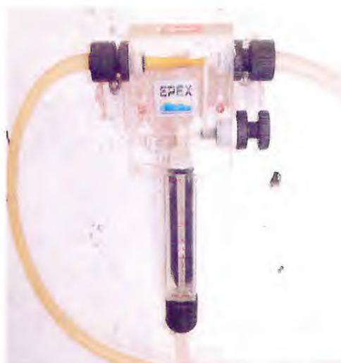
**Figura 5-** Dosador automático de cloro, que abastece todas as caixas d'água da INTERFRIOS – Intercâmbio de Frios S/A, em Fortaleza, Ceará.
