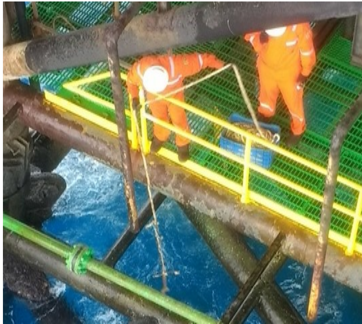
Figura 11 – Repasse de ferramentas a partir da superfície.
