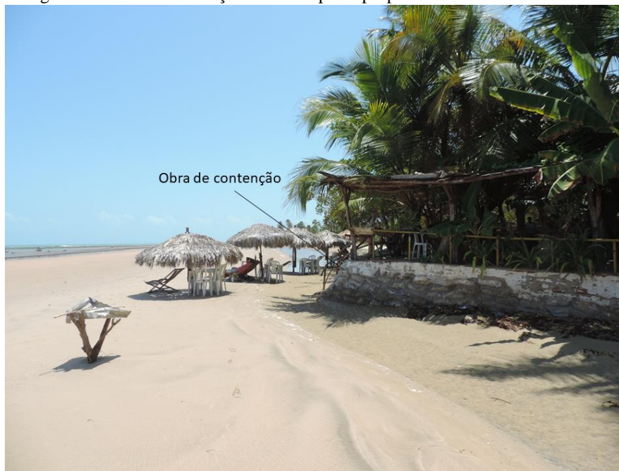
Figura 15: Obra de contenção instalada pelos proprietários do estabelecimento.
