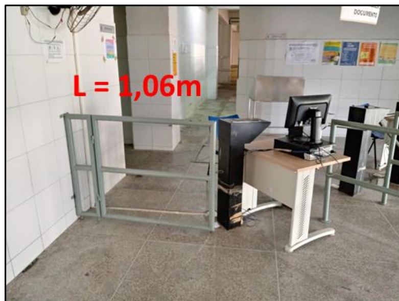
Figura 17 – Portão lateral de acesso ao refeitório
