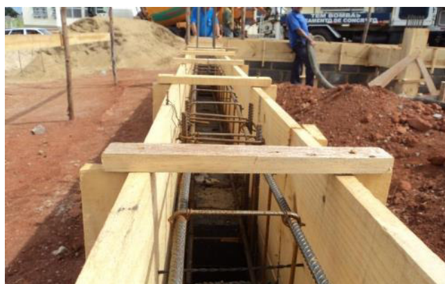
Figura 17 – Forma de viga de concreto armado
