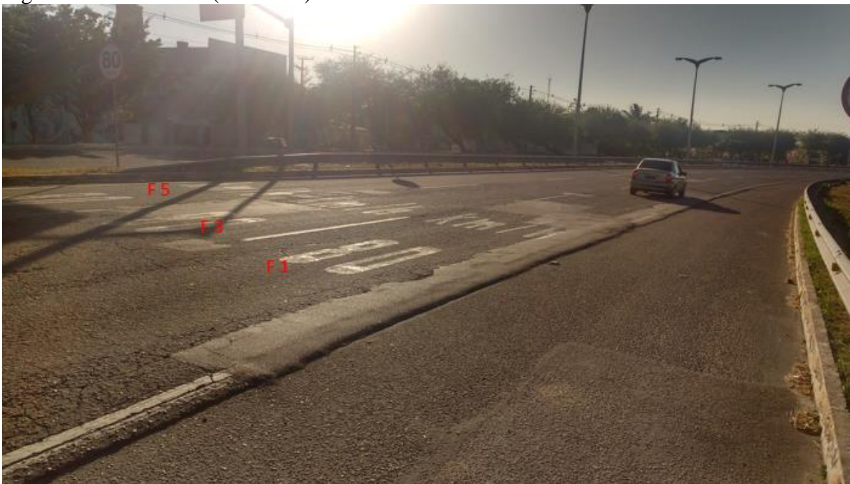
Figura 39 – Remendos (Sentido 1)
