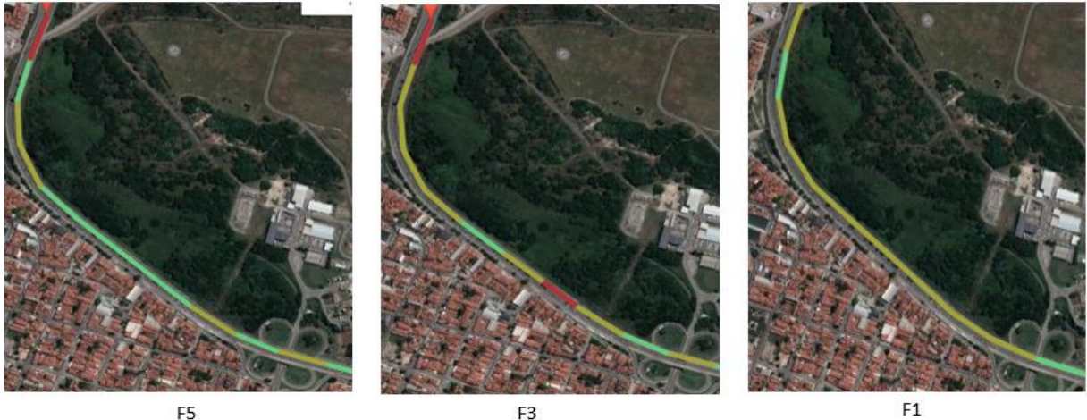
Figura 36 – Trecho crítico 4 (Sentido 1)
