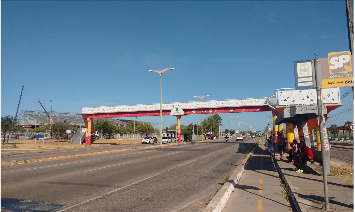
Figura 33 – Passarela de pedestre na Rodovia CE-401
