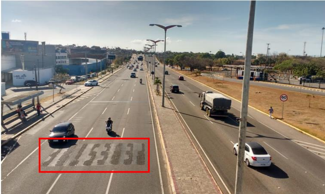
Figura 35 - Sinalização horizontal retirada
