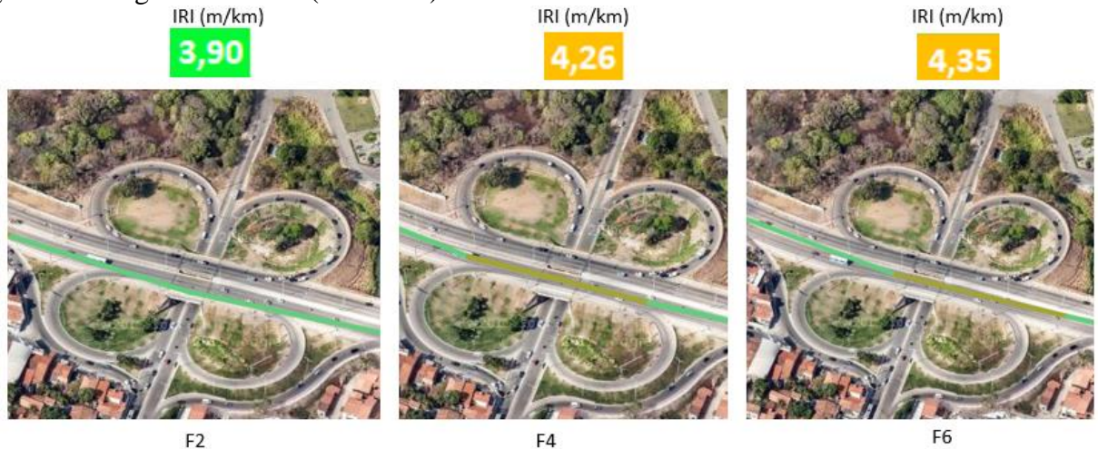
Figura 24 – Segundo viaduto (Sentido 2)
