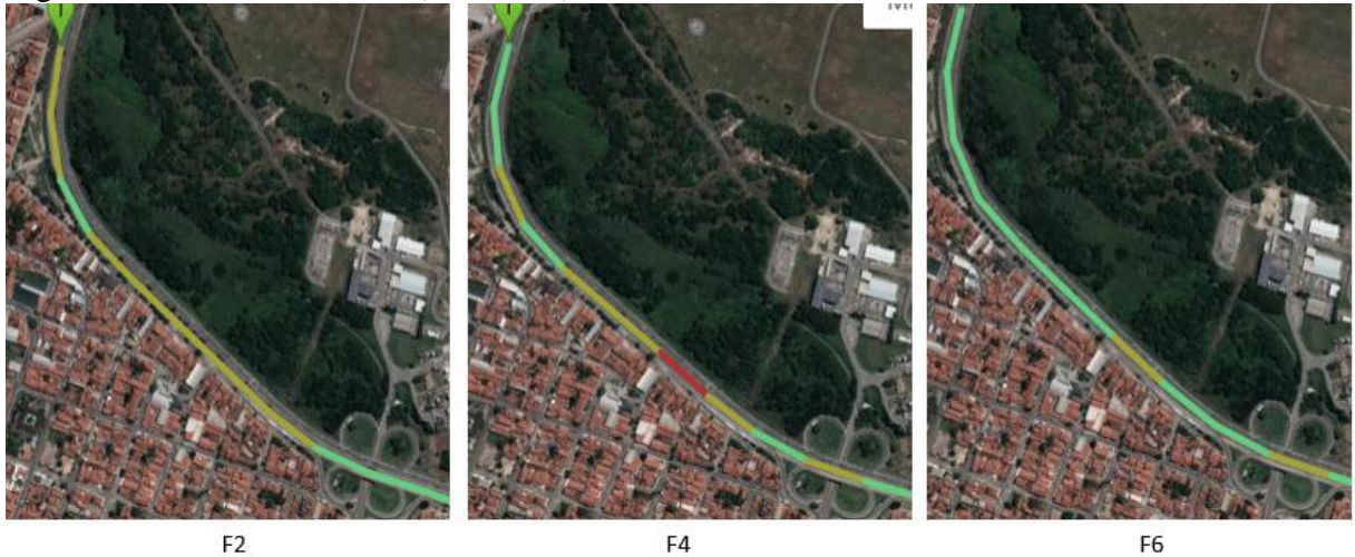
Figura 37 – Trecho crítico 4 (Sentido 2)
