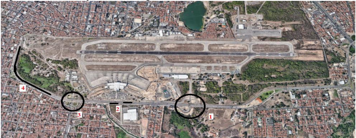
Figura 20 – Trechos específicos ao longo da Rodovia CE-401
