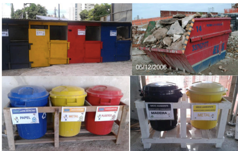
Figura 6 – Acessório utilizados pela construtora para a segregação de RCC no canteiro
