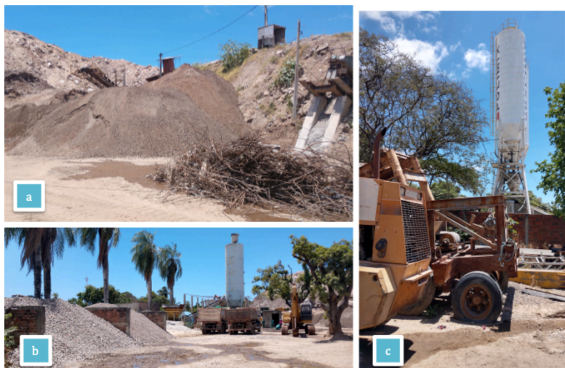
a: Produto da britagem do material classe A e aço retirado de peças de concreto armado; b: Produto de britagem; c: Veículo de transporte e britador utilizados no tratamento do resíduo Fonte: Elaborada pela autora.
