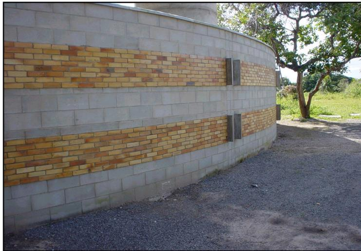
**Foto 5: Muro com blocos de concreto sem função estrutural**
