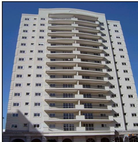
**Foto 4: Prédio em alvenaria estrutural com blocos de concreto**
