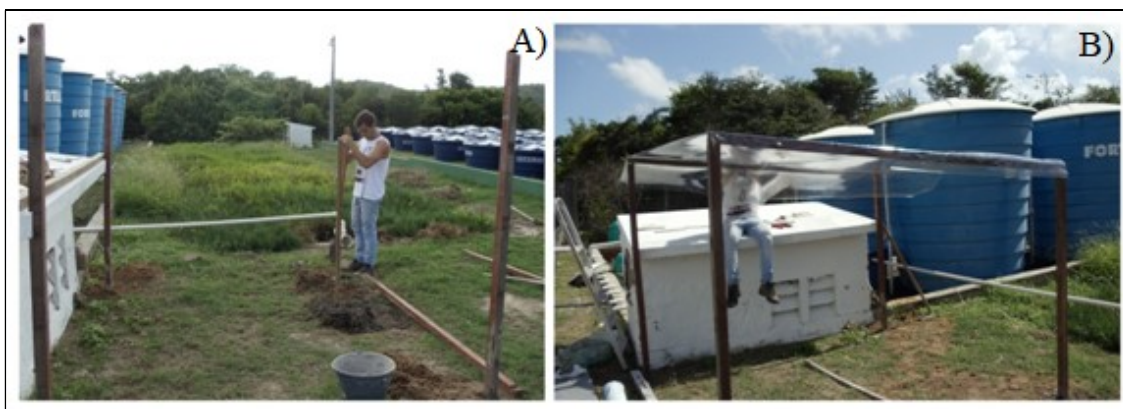
Figura 6 – Montagem de cobertura para instalação dos sistemas com a fixação das estacas no chão (A) e do plástico transparente por cima (B).
