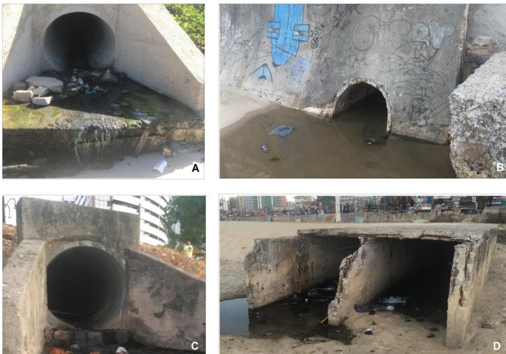
Figura 11 - Galerias Pluviais da orla de Fortaleza. a) Galeria do Bairro Cristo Redentor. b) Galeria do Bairro Meireles. c) Galeria do Bairro Mucuripe d) Galeria do Bairro Meireles.
