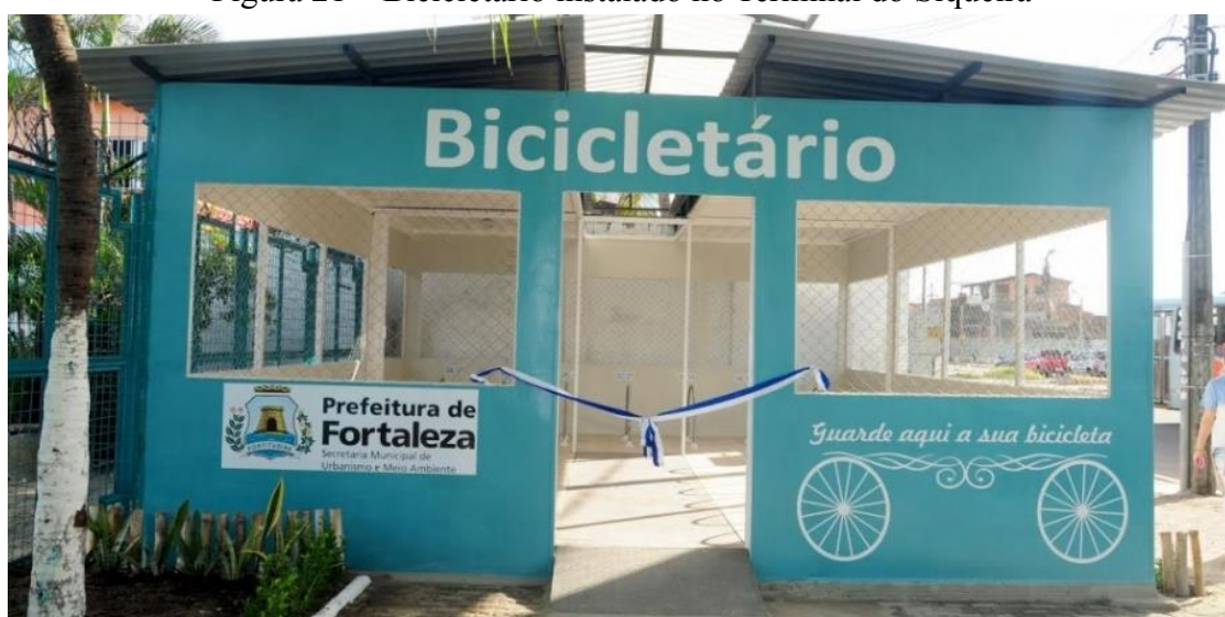
Figura 21 – Bicicletário instalado no Terminal do Siqueira
