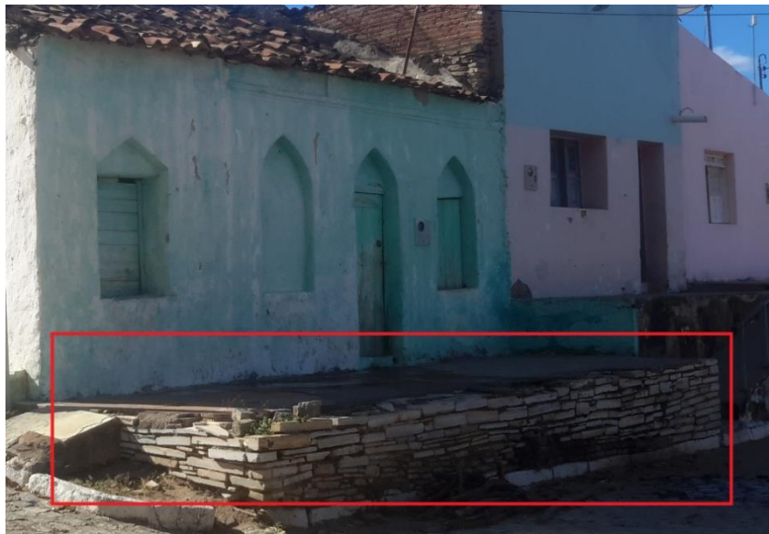
Figura 8 - Calçada de residência feita de RPC no município de Santana do Cariri
