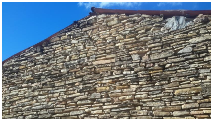
Figura 6 - Parede externa de residência feita de RPC.
