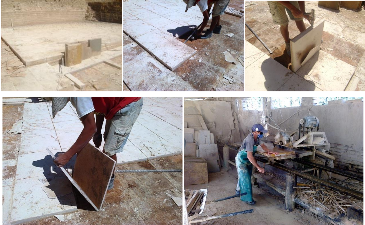
Figura 10 - Processo de extração e beneficiamento da Pedra Cariri. (a) Extração de camadas de solo até atingir afloramento; (b) Retirada manual da lajota; (c) Início do deslocamento manual da lajota; (d) Término do deslocamento manual (e) Esquadrejamento nas dimensões comerciais.
