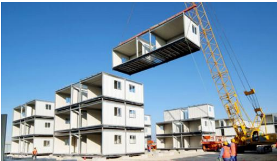
Figura 22 – Transporte vertical dos módulos.
