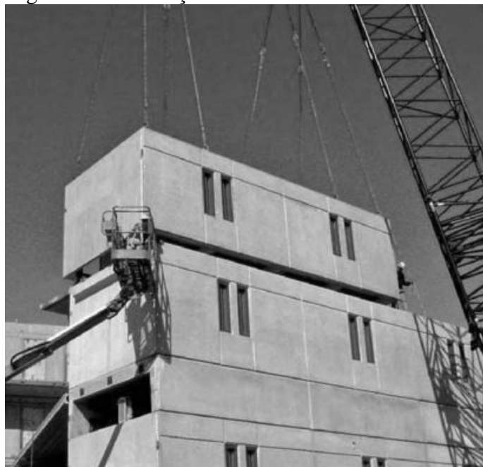
Figura 08 – Instalação de módulos de concreto.
