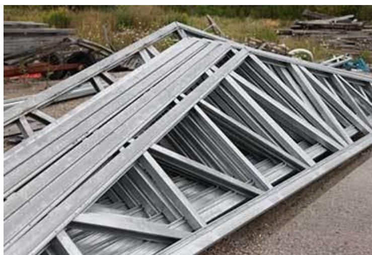
Figura 03 – Exemplo de Nível 1 – Treliças de telhados
