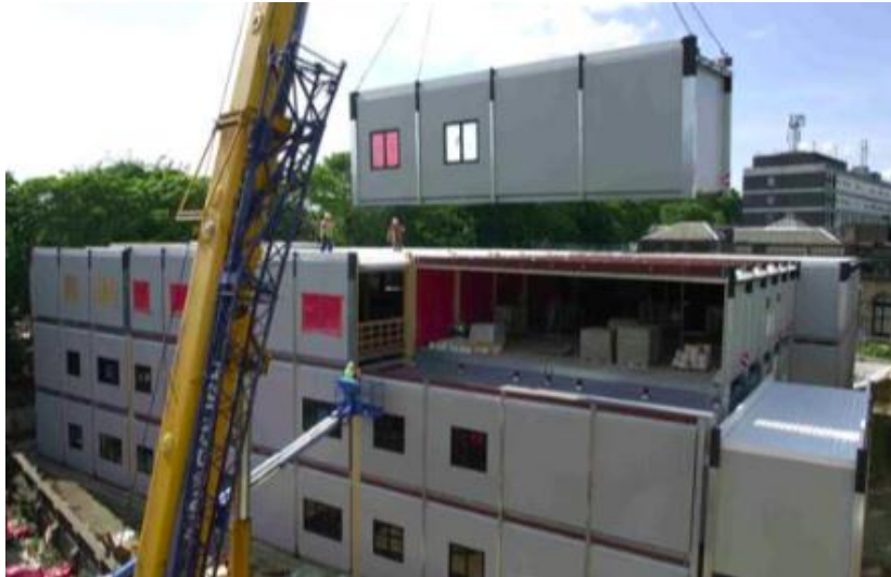
Figura 20 – Construção de um hospital com módulos com suportes de canto
