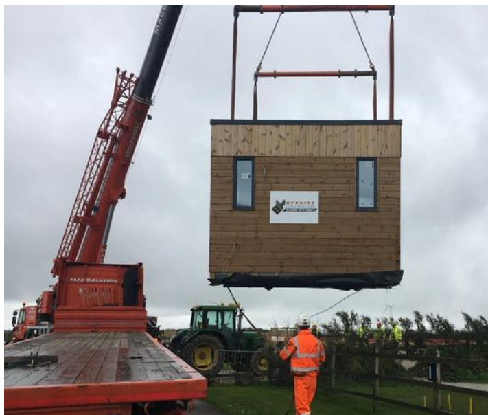
Figura 12 – Transporte de módulo em Light Wood Frame .
