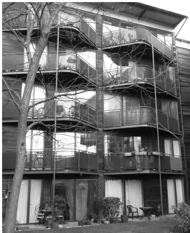
Figura 07 – Construção do Murray Grove, Londres.
