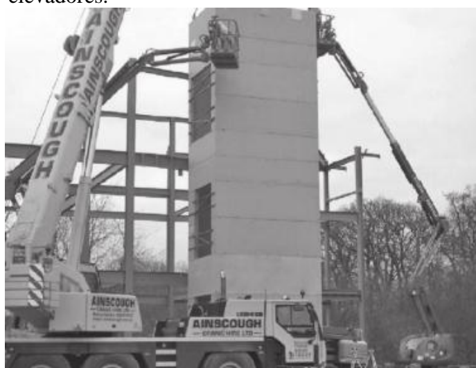
Figura 11 – Núcleos de concreto para caixa de elevadores.
