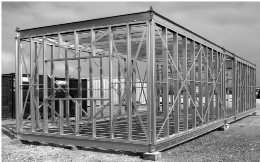
Figura 16 – Módulo parcialmente aberto com corredor.
