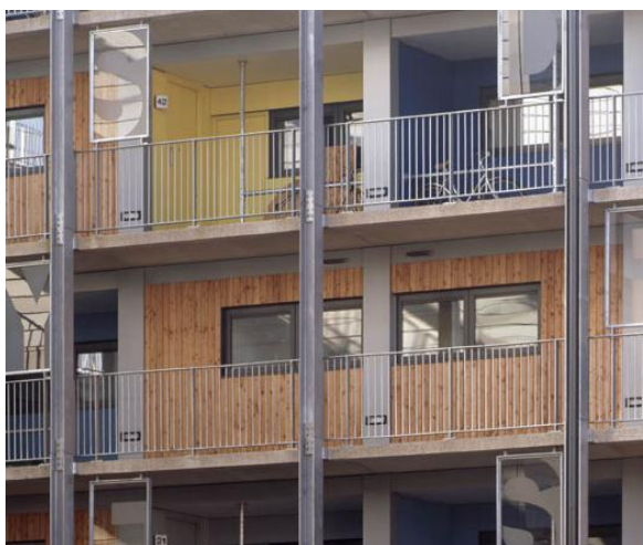
Figura 35 – Varandas cobertas e acopladas aos módulos do Raines Court.
