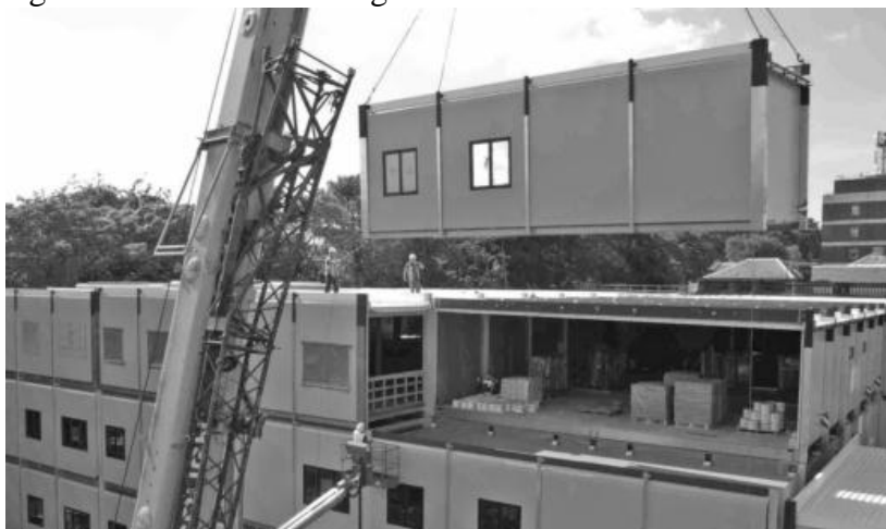
Figura 02 – Fase de montagem no canteiro.
