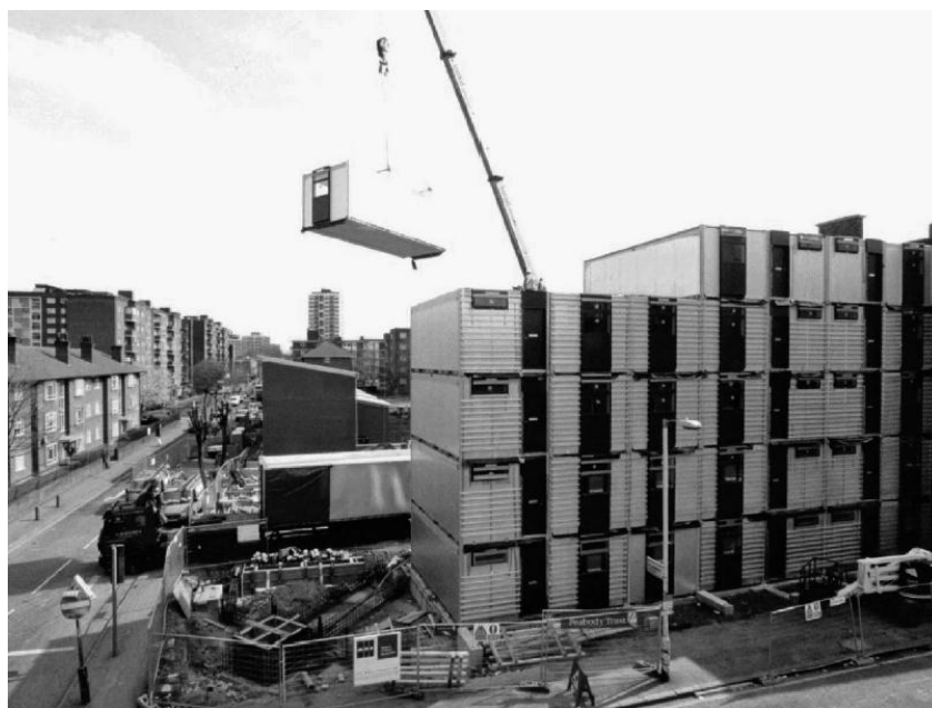
Figura 06 – Fase de montagem do Murray Grove, Norte de Londres.
