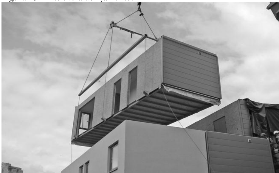
Figura 23 – Estrutura de içamento.
