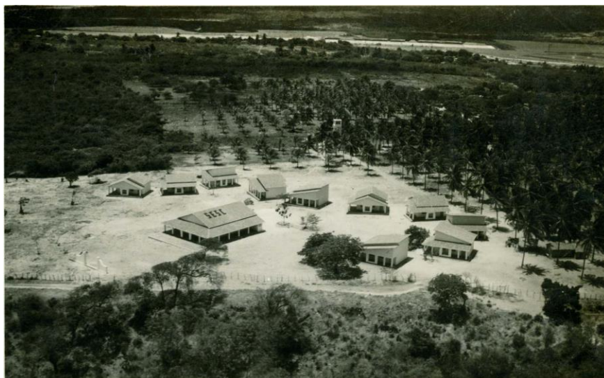
Figura 12 – Vista aérea da Colônia de Férias do SESC, Caucaia
