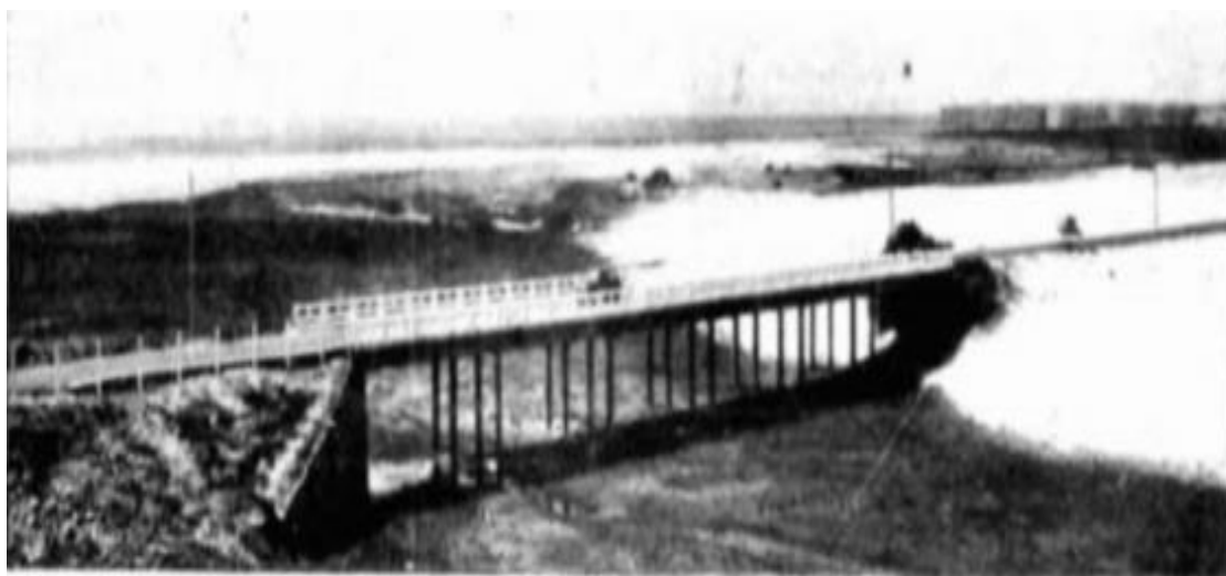
Figura 16 – Ponte sobre o Rio Barra Nova, entre Icaraí e Tabuba
