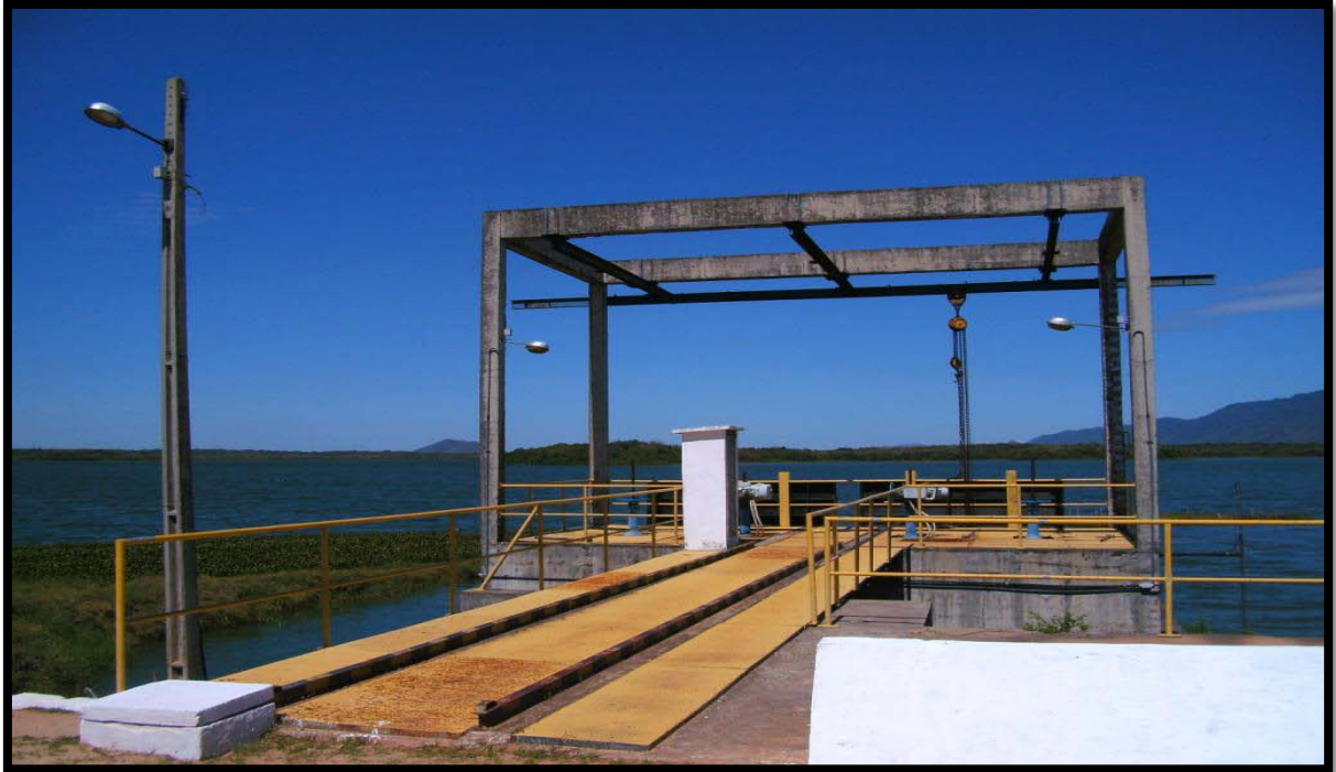
Figura 7– Fotografia do açude Gavião, detalhe para a área de captação de água.3
