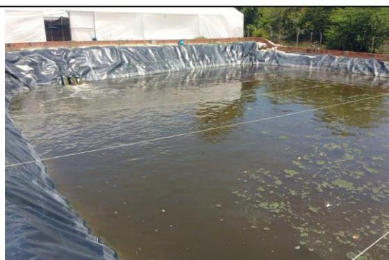
Figura 12: Bacia para o reúso de água (800 m<sup>3</sup>)
