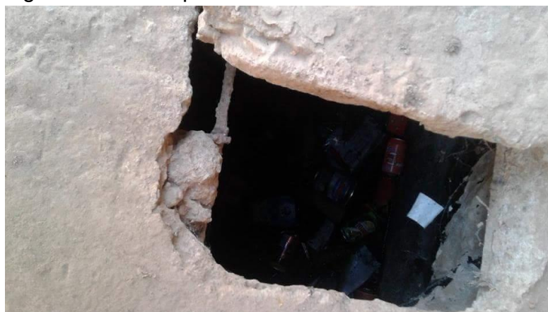
Figura 21 – Exemplo de latrina em moradia de Mindará
