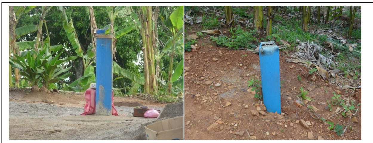
Figura 26 - Poços perfurados sem sucesso na CQSE
