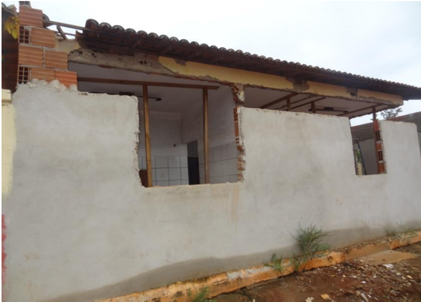
Figura 6 - Obra de posto de saúde
