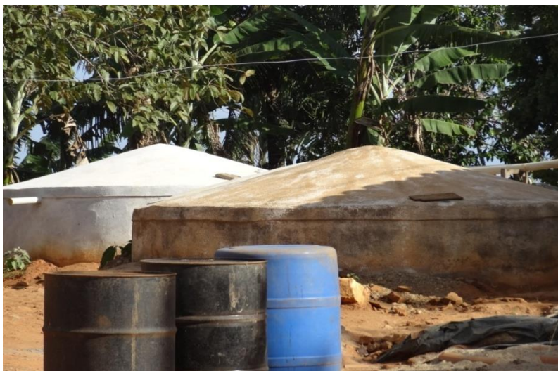
Figura 20 - Cisternas próprias e da Obra Kolping.
