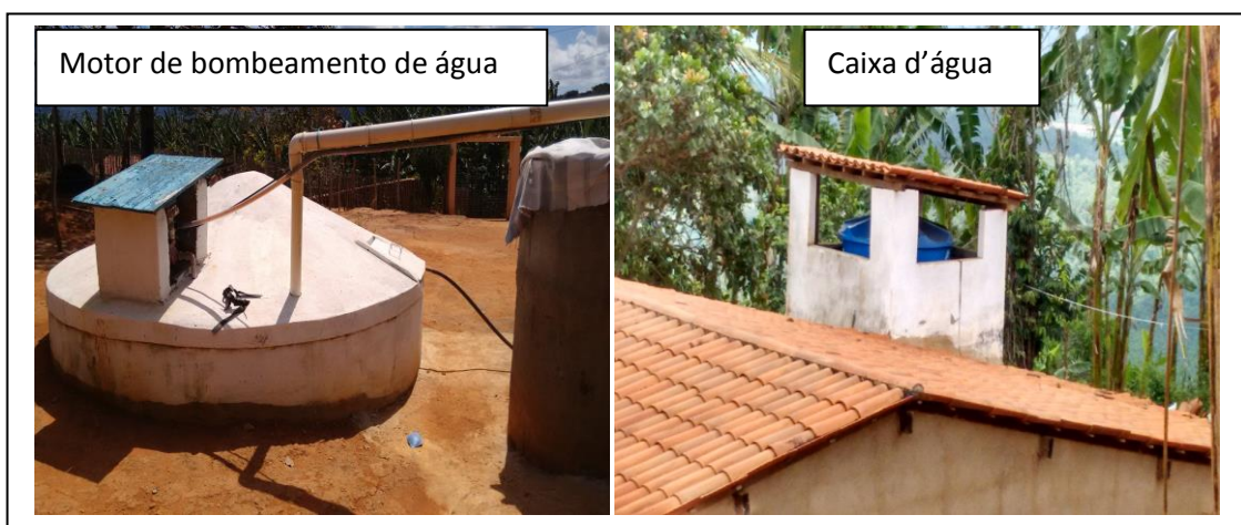
Figura 19 - Técnica de manejo das águas, motor de bombeamento de água para caixa de água.
