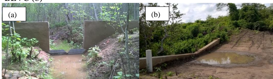
Figura 4– Vertedouros para medida do volume escoado na MEVC (a) e na BEVC (b)
