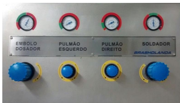
Figura 25 – Identificação das faixas de trabalho na estação de dosagem
