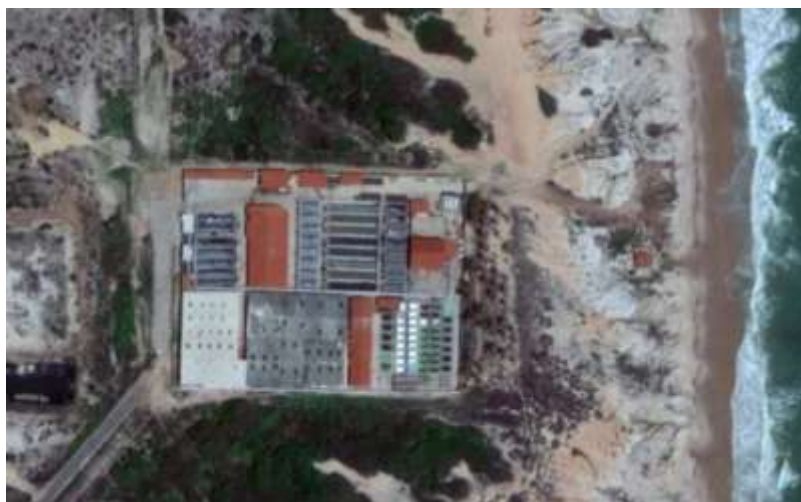
Figura 04 – Vista aérea do laboratório da empresa CELM Aquicultura Ltda, localizado na praia de Lagoa do Mato, município de Aracati - CE.
