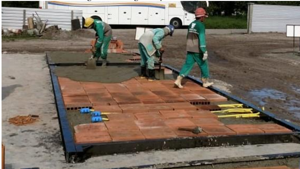
Figura 3: Montagem de painel de alvenaria.
