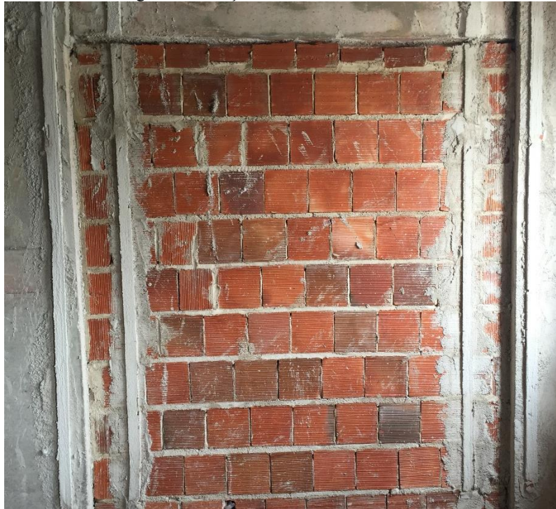
Figura 1: Vedação em alvenaria tradicional.
