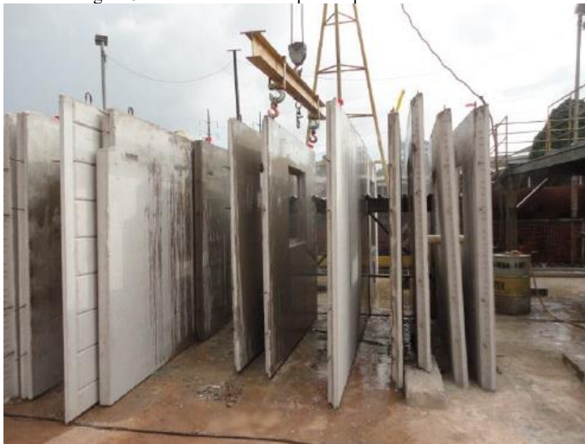
Figura 5: Armazenamento de painéis pré-fabricados de concreto.
