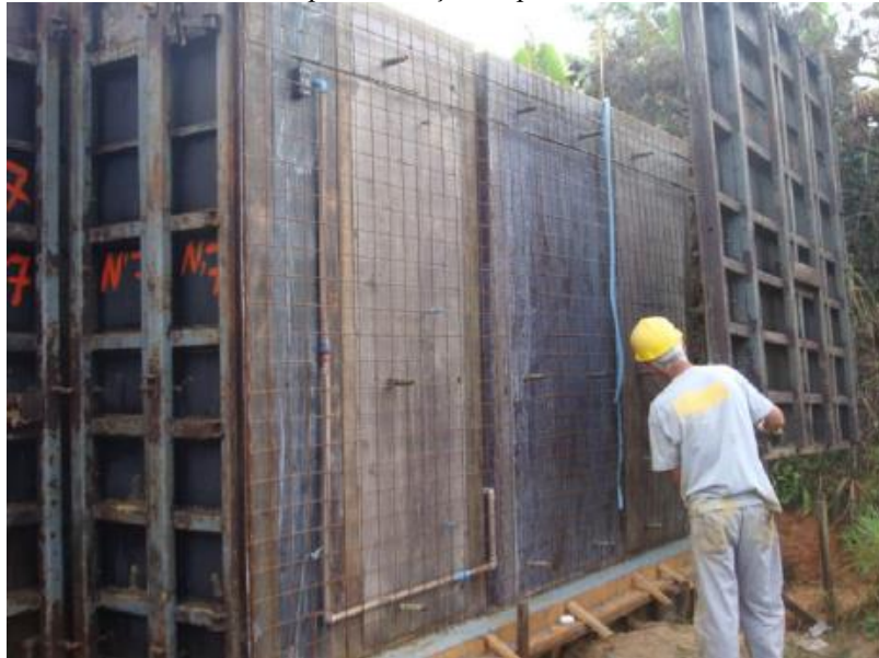
Figura 4: Fechamento de formas para execução de paredes de concreto moldadas no local.
