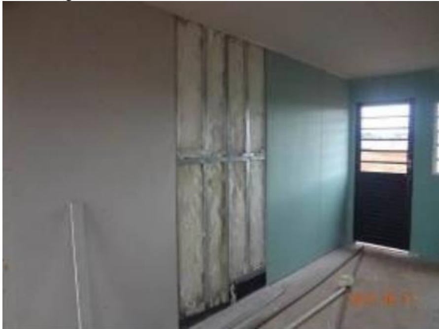
Figura 6: Estrutura de steel frame com isolamento de lã de vidro.
