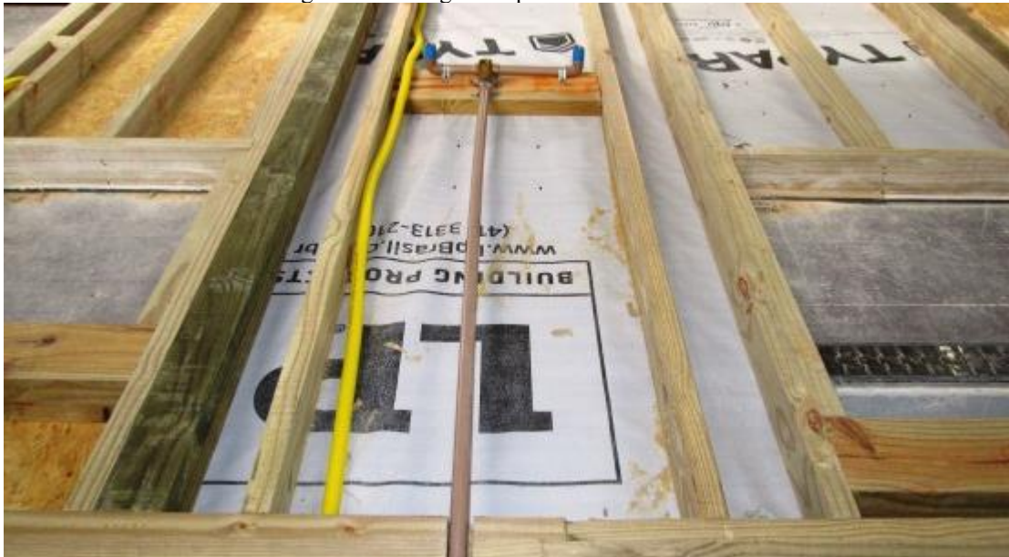
Figura 7: Montagem de painel de wood frame.
