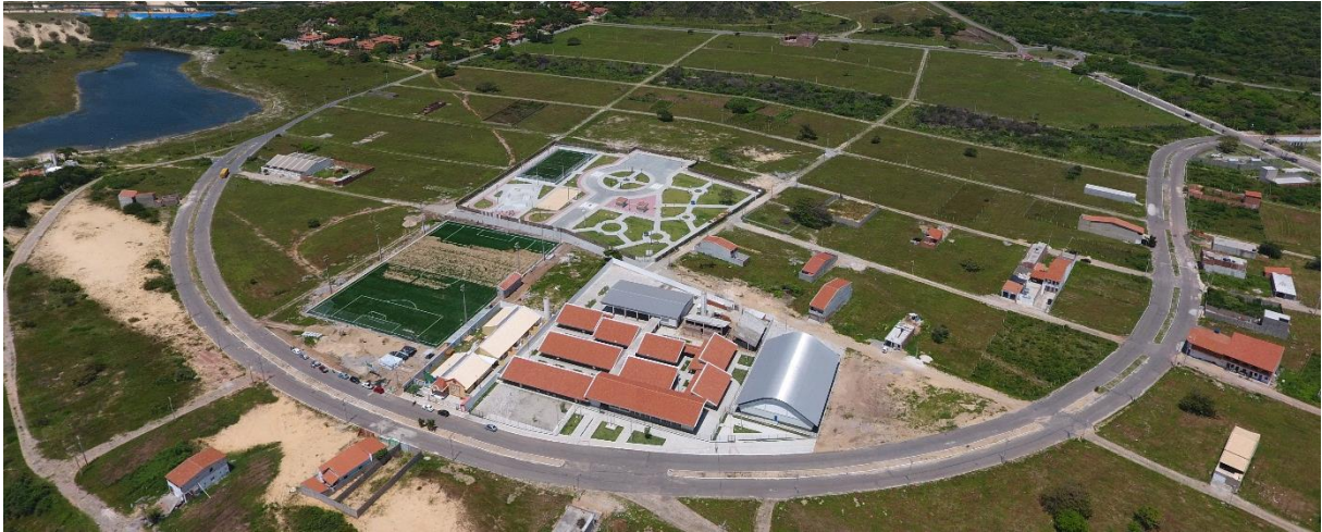
Figura 31 - Vista aérea do loteamento Porto Pecém, evidenciando a baixa ocupação residencial e a presença de algumas infraestruturas.
