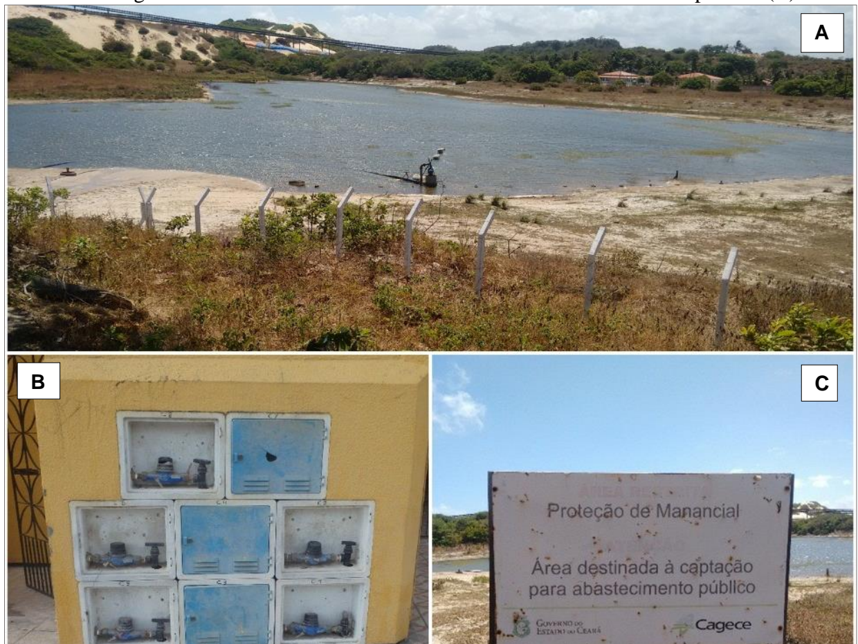
Figura 32 - Manancial utilizado para a provisão (A), medidores de consumo residencial (B) e aviso na lagoa informando se tratar de uma área restrita ao abastecimento público (C).
