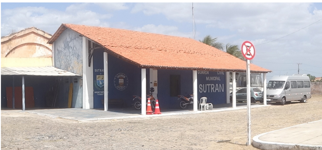
Figura 58. Antiga Balança depois do acréscimo na cobertura Fonte: acervo da autora
