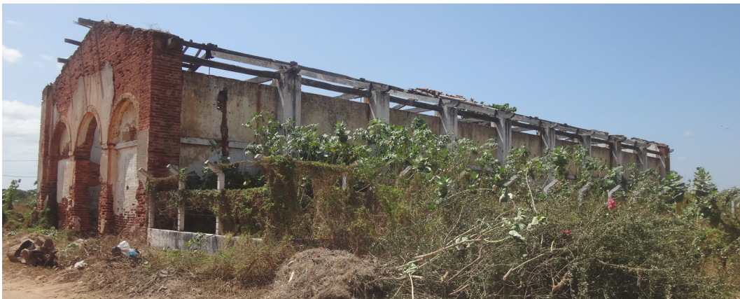
Figura 54. Antigo Galpão de Locomotivas
