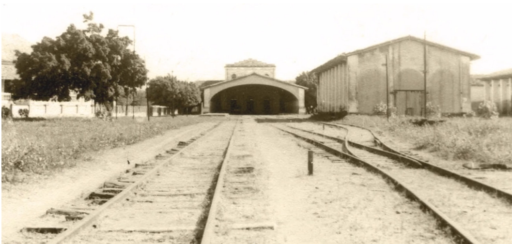
Figura 02. A estação ferroviária de Camocim Fonte: Arquivo IPHAN/CE
