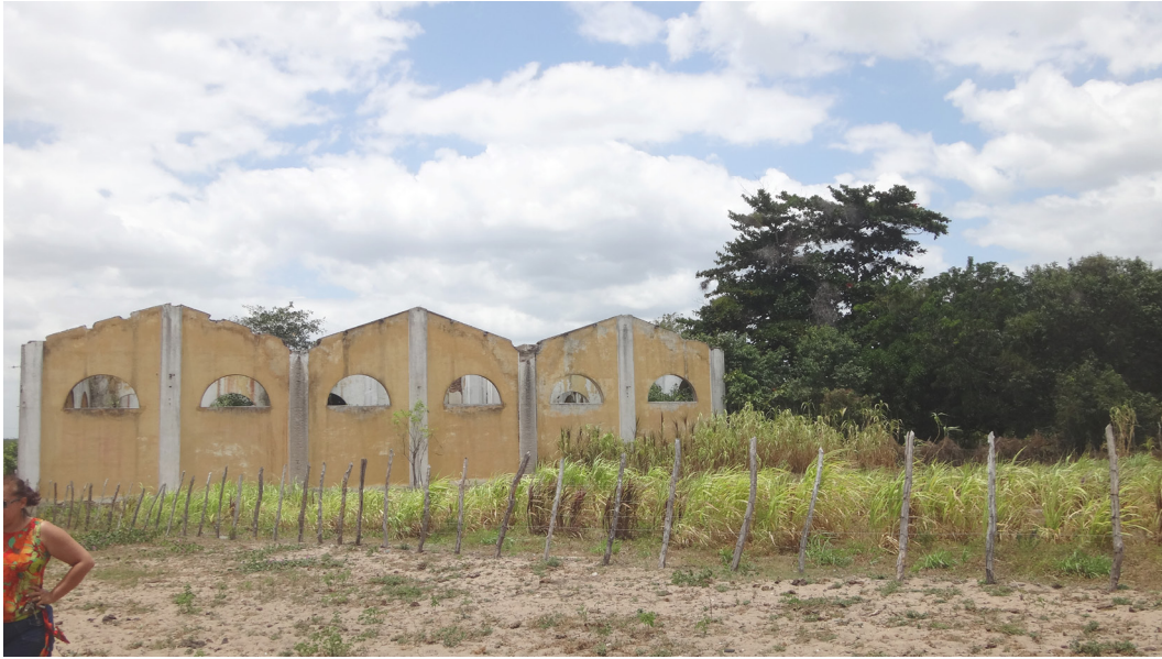
Figura 47. Maciço vegetal ao lado das ruínas das Oficinas Fonte: acervo da autora
