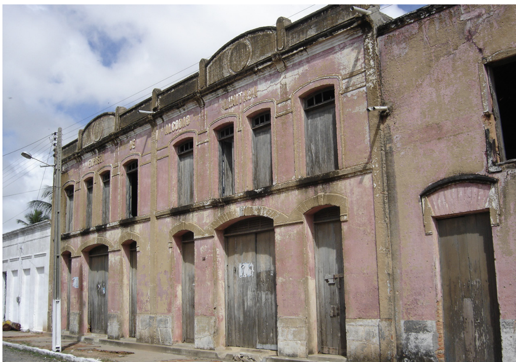
Figura 51. Edifícios abandonados na R. Gen. Tibúrcio Cavalcante
