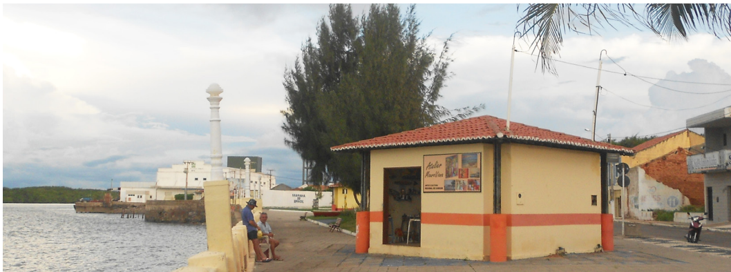
Figura 31. Quiosque bloqueando a vista para o edifício da Estação Ferroviária
