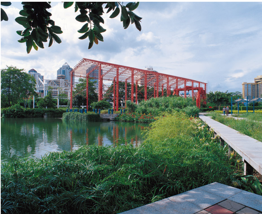
Figura 80. Estruturas metálicas restauradas
