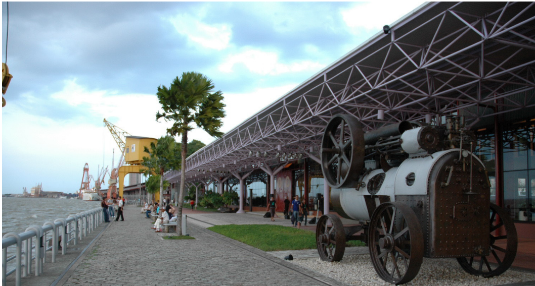
Figura 79. Marquise metálica e maquinário restaurado
