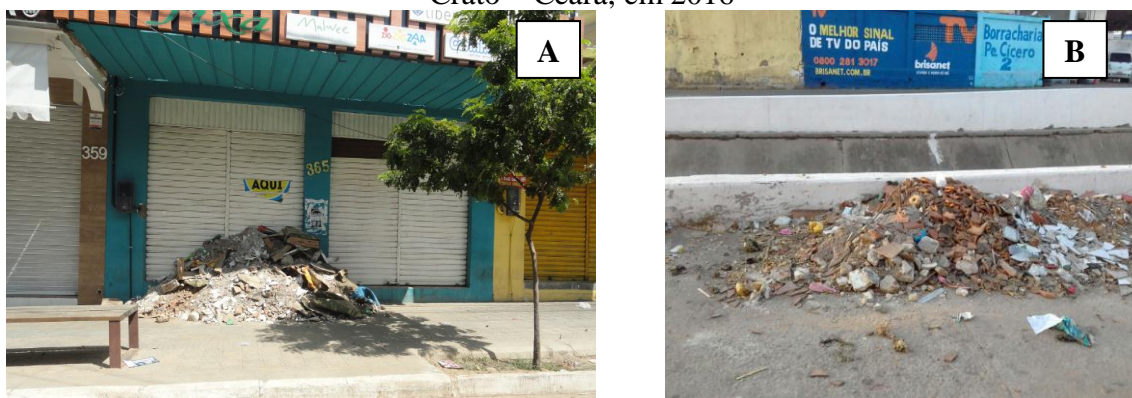
Figura 26 – Resíduos da construção civil (A = resíduos da construção civil no centro comercial do Crato, B = resíduos da construção civil à margem do canal do rio Grangeiro). Crato – Ceará, em 2016
