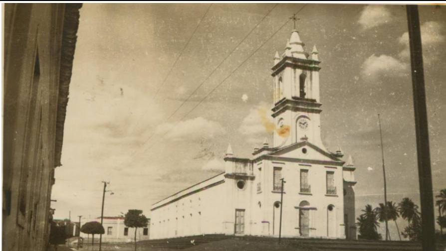
Figura 173 – Igreja Matriz de São José dos Cariris Novos, em Missão Velha-CE. Os corredores laterais e a torre foram construídos em 1925 (RESCALA, 1941).
