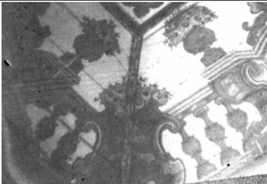
Figura 124 – Detalhe do da balaustrada e cartela de arremate do forro da capela do Bom Jesus dos Navegantes (1793), em Granja-CE
