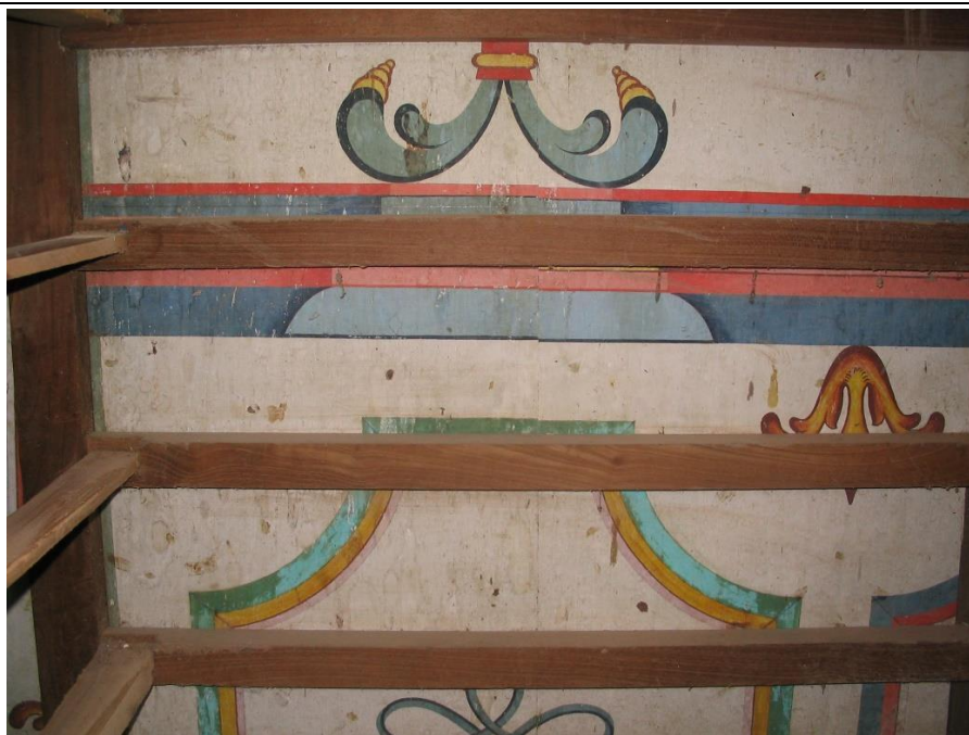
Figura 53 – Detalhe de fragmento do retábulo da Capela de Itans, em Itapiúna-CE
