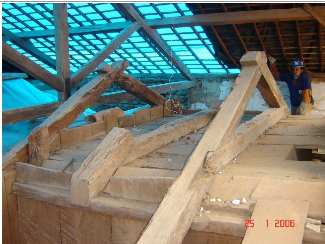
Figura 369 – Coberta em tesoura canga-de-porco da capela-mor de Nossa Senhora da Assunção, em Viçosa do Ceará.
