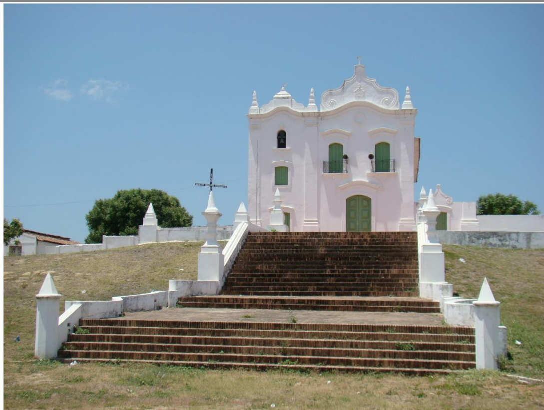
Figura 312 – Igreja de N. Sr. a da Conceição do Monte, em Icó.
