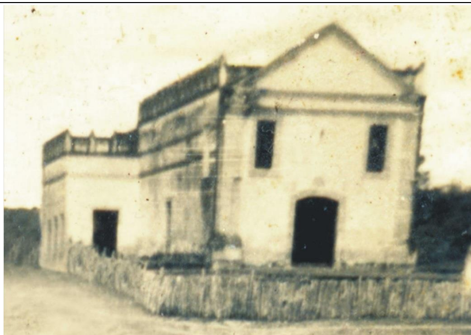
Figura 37: Capela de Nossa Senhora do Livramento, em Morada Nova-CE.
