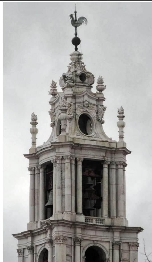
Figura 200: Torre do Convento de Mafra
