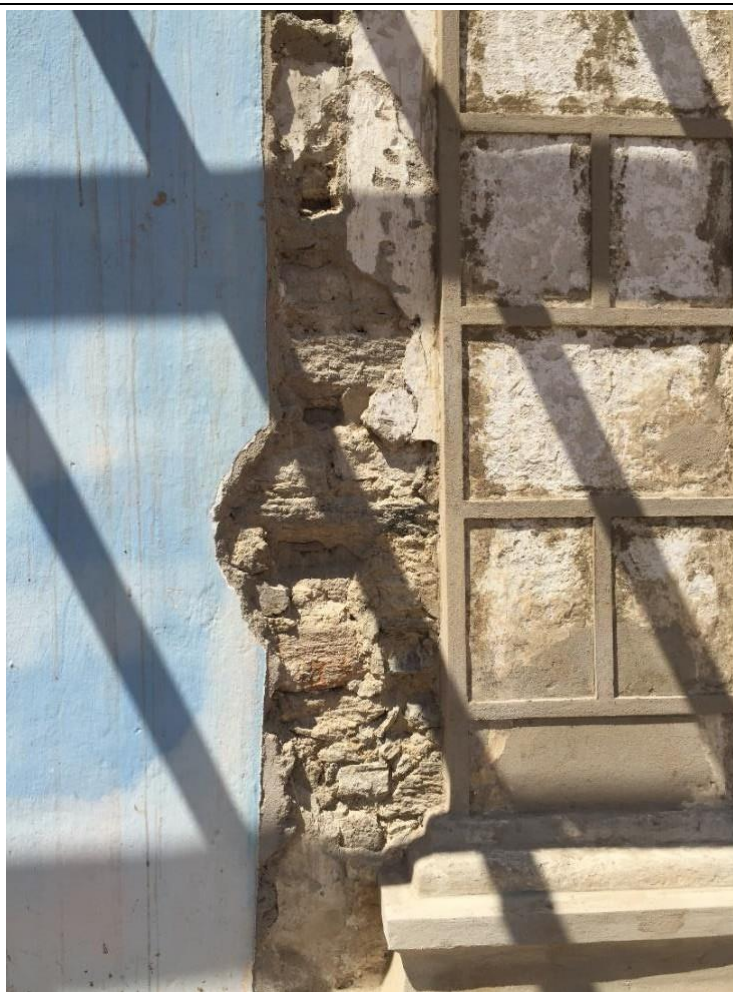
Figura 344 – Detalhe construtivo do cunhal da capela de Itans.
