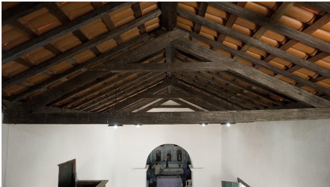
Figura 367 – Coberta em tesoura canga-de-porco da capela de Itans, Itapiúna-CE
