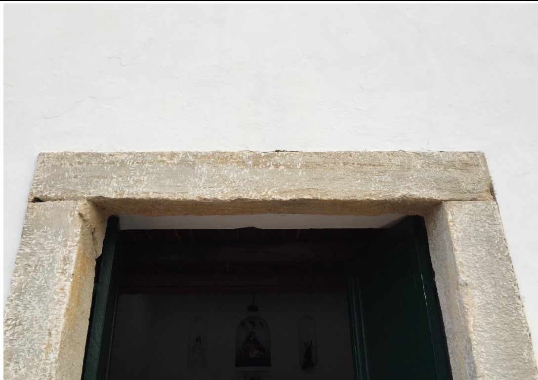
Figura 355 – Detalhe da portada em arenito da Capela de Mata Fresca, em Aracati-CE
