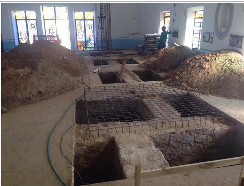
Figura 338 – Evidenciação do alicerce em pedra da igreja de Trairí
