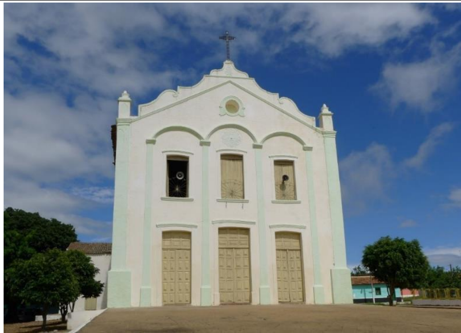
Figura 256 – Capela de São Gonçalo, em Ipueiras-CE.
