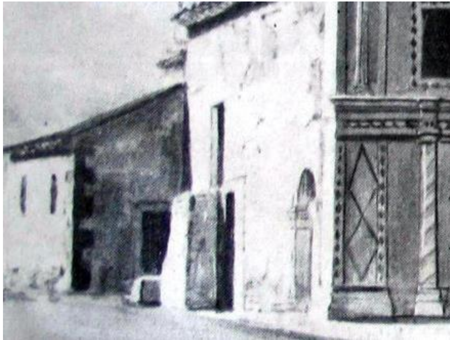
Figura 305 – Detalhe do cunhal em silharia de pedra. Capela de Nossa Senhora do Rosário, em Tauá, em 1859.
