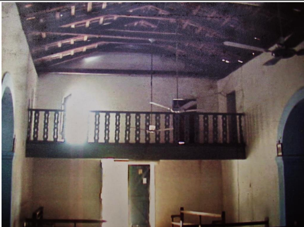
Figura 370 – Coberta em tesoura canga-de-porco da capela de Santo Antônio de Ibuçu, em Granja-CE
