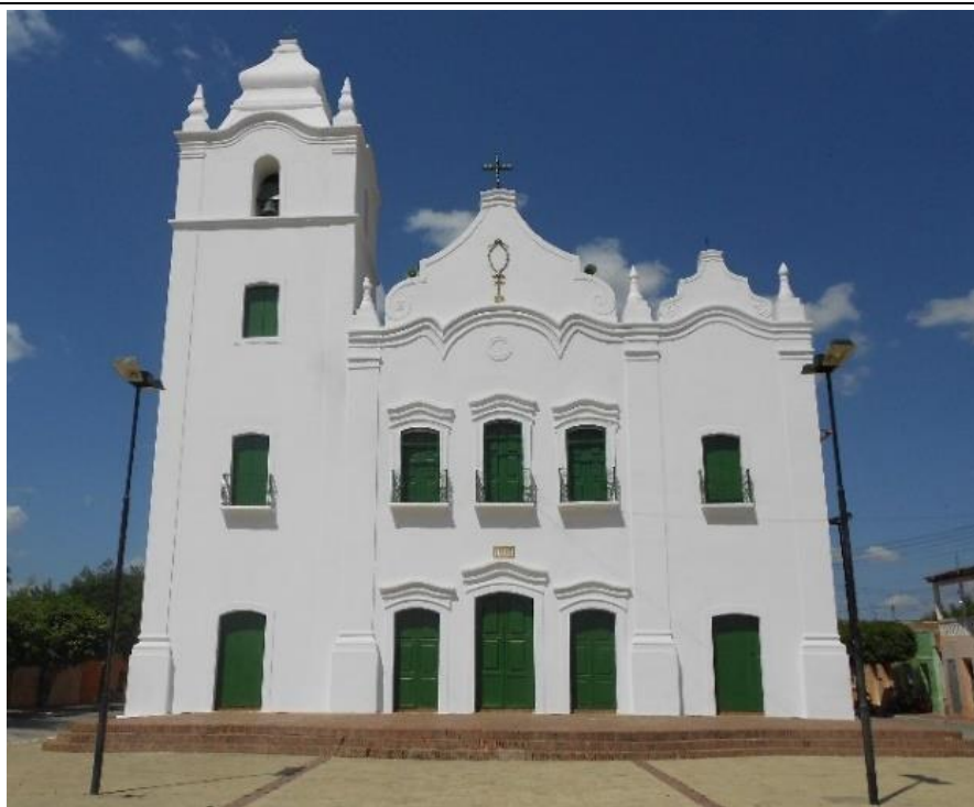
Figura 28: Capela do Rosário dos Pretos, em Icó-CE.
