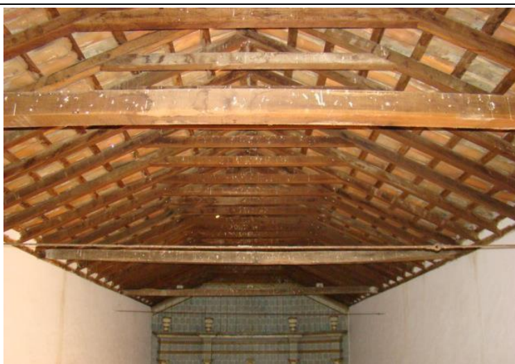
Figura 365 – Coberta em caibro-armado da igreja de Nossa Senhora da Conceição do Monte, em Icó -CE
