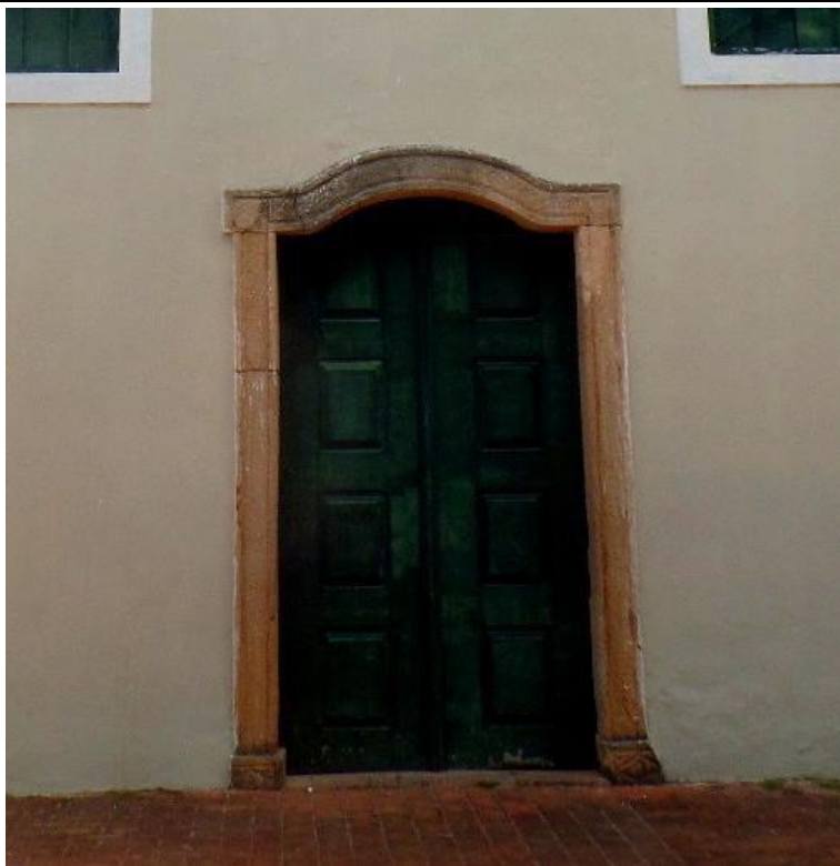
Figura 356 – Detalhe da portada em arenito da Capela de Siupé.
