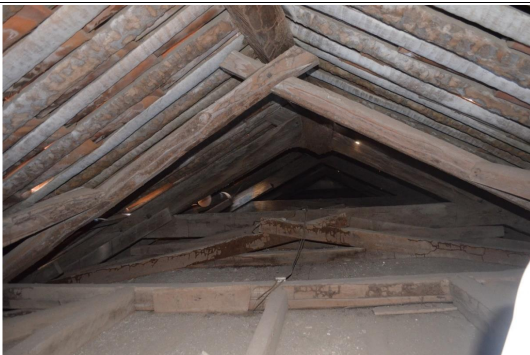
Figura 368 – Coberta em tesoura canga-de-porco da capela de Nossa Senhora do Rosário, em Aracati-CE
