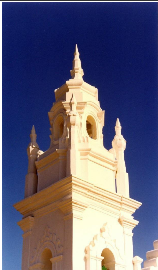
Figura 199: Torre da igreja de Almofala
