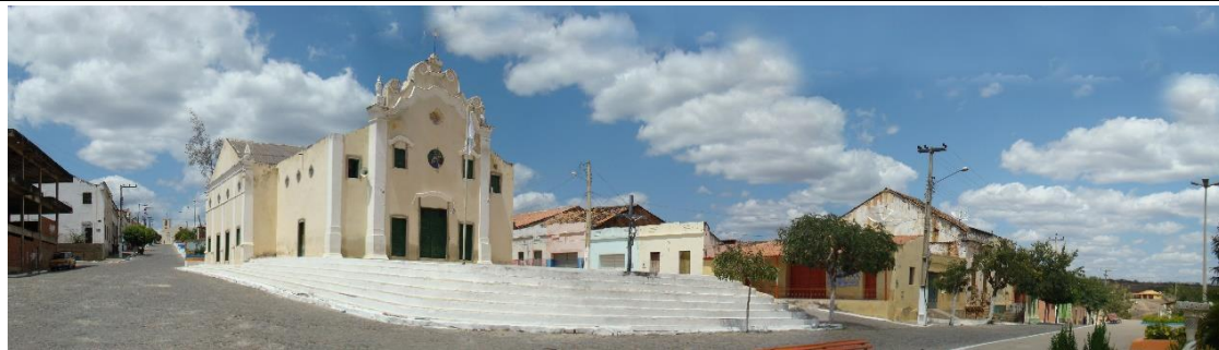
Figura 314 – Igreja de N. Sr. a da Purificação, em Saboeiro.
