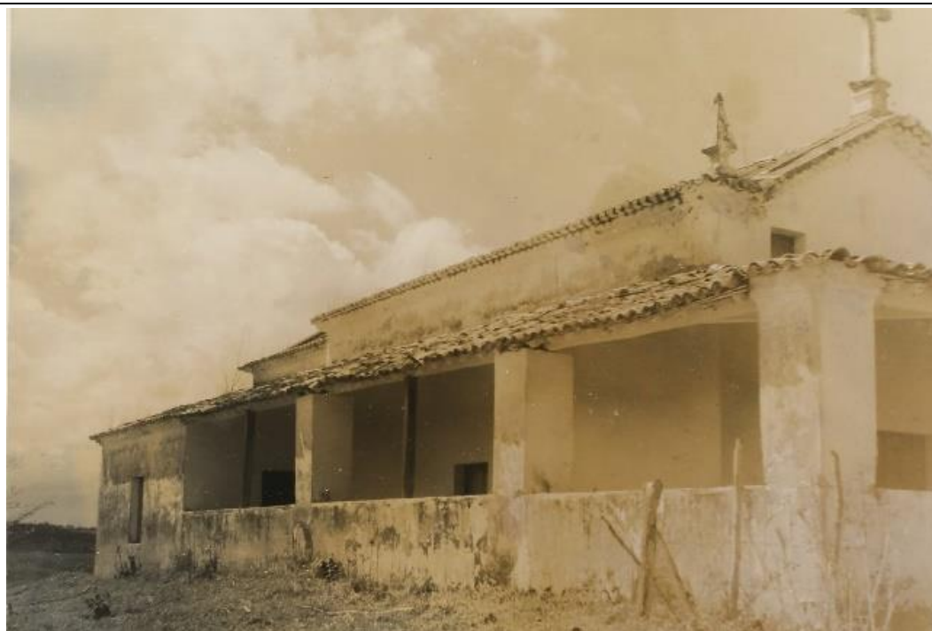
Figura 46 – Capela de Nossa Senhora da Conceição de do Engenho Caeira, em Santo Amaro das Brotas-SE.
