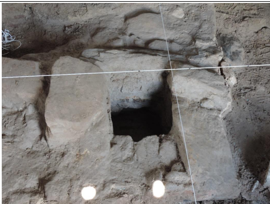
Figura 340 – Detalhe do alicerce em pedra da capela de Itans com espaço para encaixe do esteio de aroeira.
