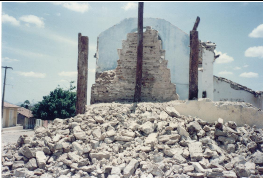
Figura 339 – Esteios em aroeira embutidos na alvenaria da capela de Itans
