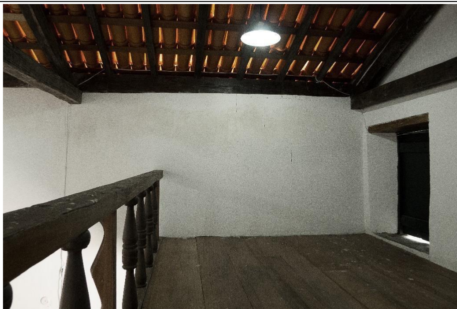
Figura 56 – Balastrada do côro da Capela de Itans, em Itapiúna-CE
