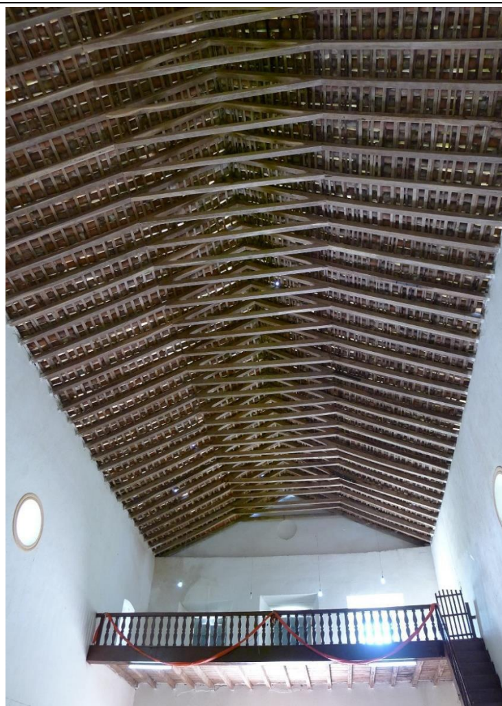
Figura 366 – Coberta em caibro-armado da igreja de São Gonçalo da Serra dos Côcos, em Matriz, Ipueiras-CE
