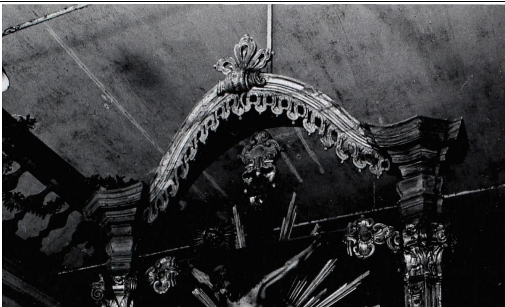
Figura 118 – Detalhe do dossel e sanefa do retábulo do côro alto do Mosteiro de São Bento, em Olinda-PE.
