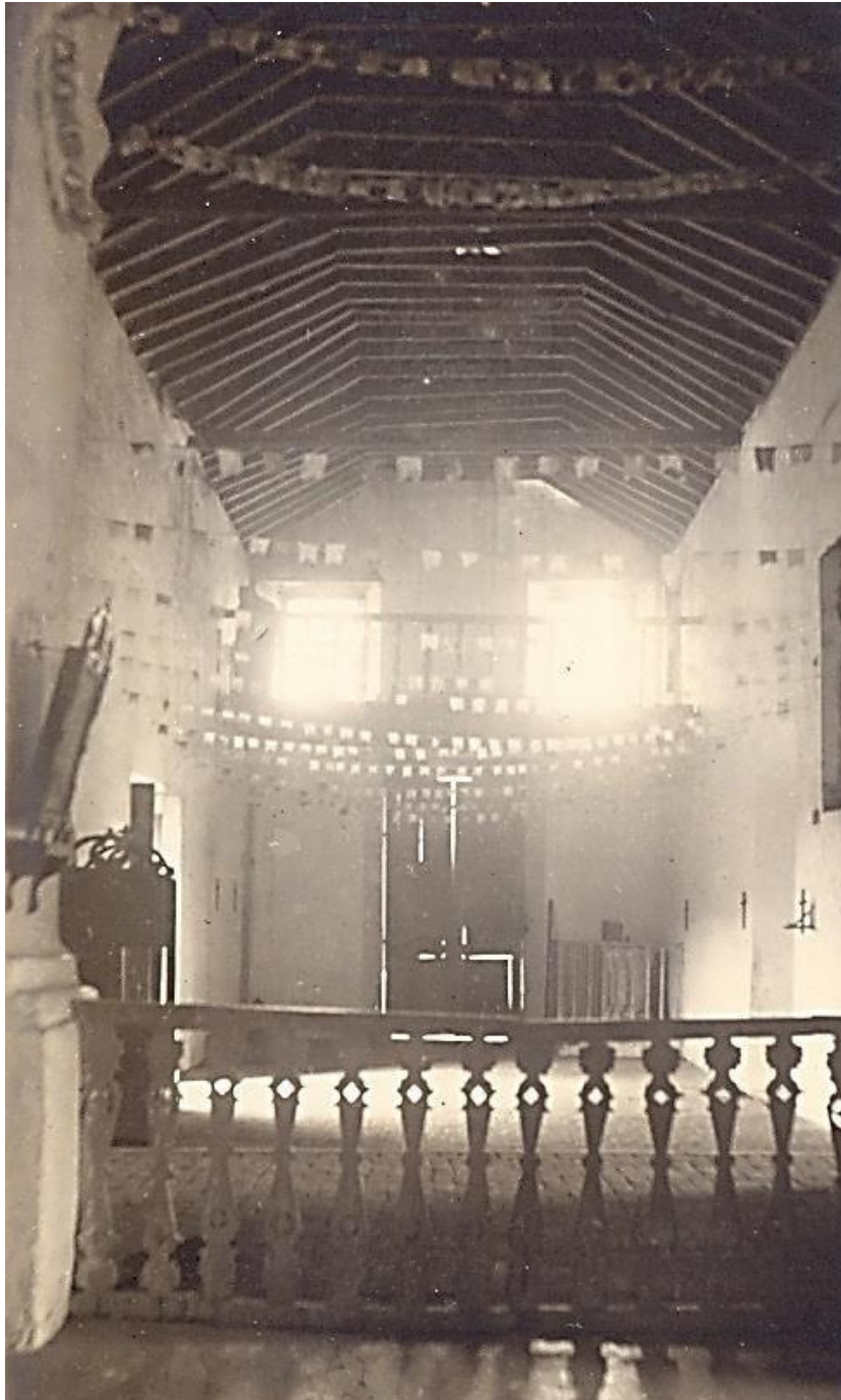
Figura 206 – Igreja matriz de Arneiroz, vendo-se o entesouramento remanescente das obras setecentistas
