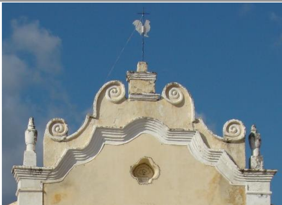
Figura 151 – Frontão da igreja de Nossa Senhora da Purificação de Saboeiro-CE.
