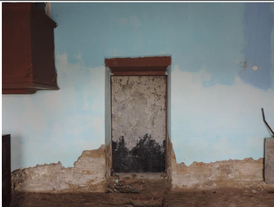
Figura 345 – Alvenaria de pedra da capela de Itans
