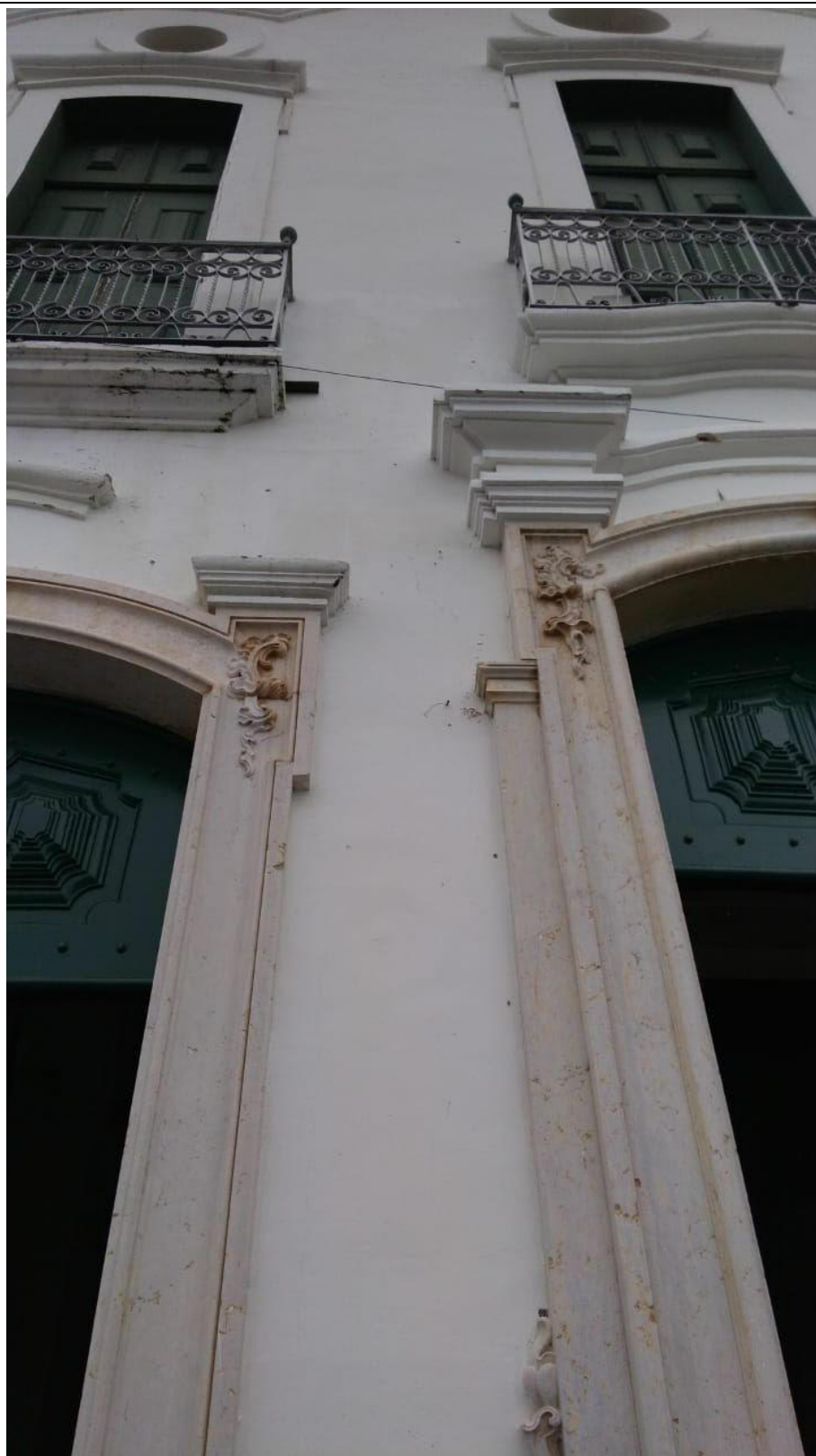
Figura 164 – Detalhe das portadas em lioz da igreja matriz de Nossa Senhora da Conceição de Sobral, 1780.
