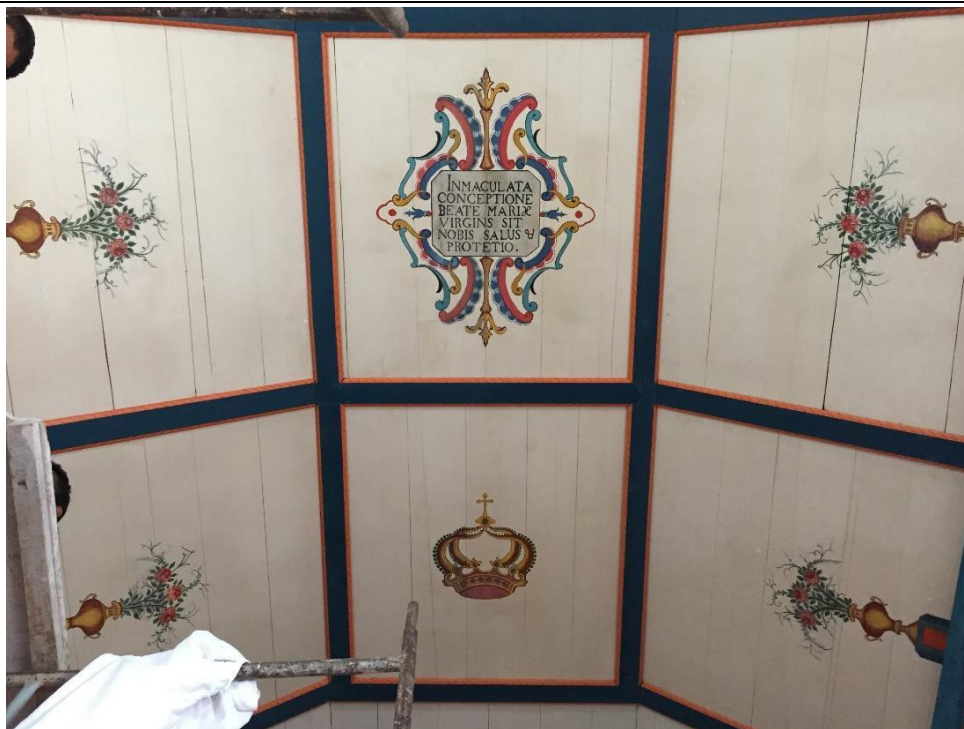
Figura 223 – Detalhe do forro da capela-mor da Capela de Itans, em Itapiúna-CE
