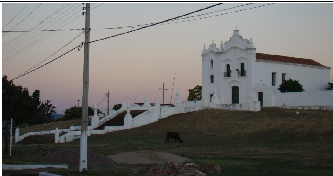
Figura 313 – Igreja de N. Sr. a da Conceição do Monte, em Icó.
