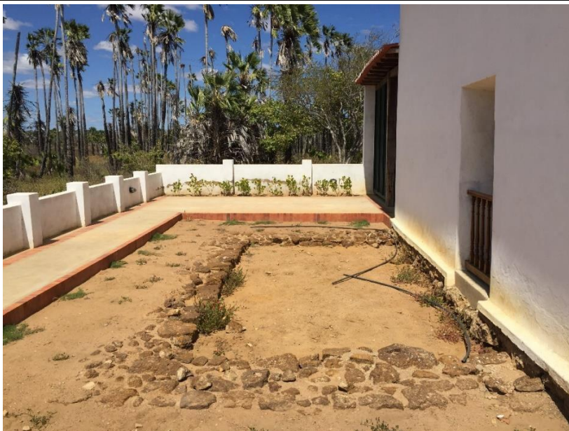
Figura 337 – Afloramento do alicerce em pedra da capela de Mata Fresca
