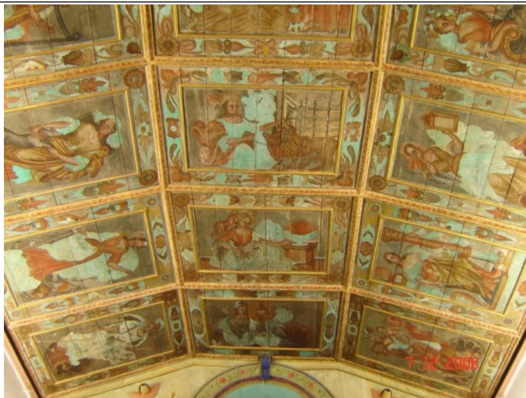
Figura 102 – Forro da igreja de Nossa Senhora da Assunção de Viçosa do Ceará-CE.
