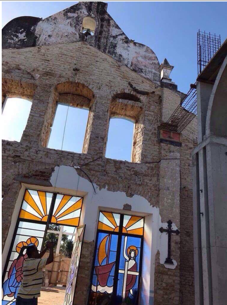
Figura 341 – Alvenaria em tijolos do frontispício da igreja de Trairi
