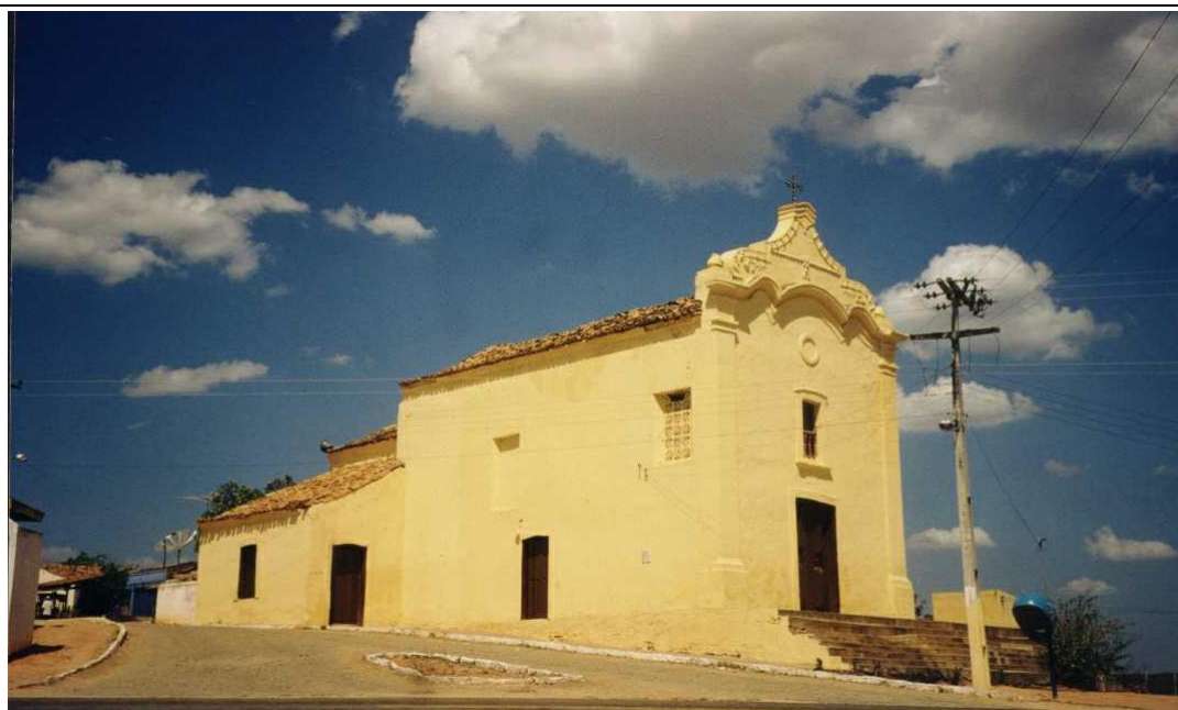
Figura 31: Aspecto geral da implantação e volumetria da Capela de São Caetano, em Várzea Alegre-CE.
