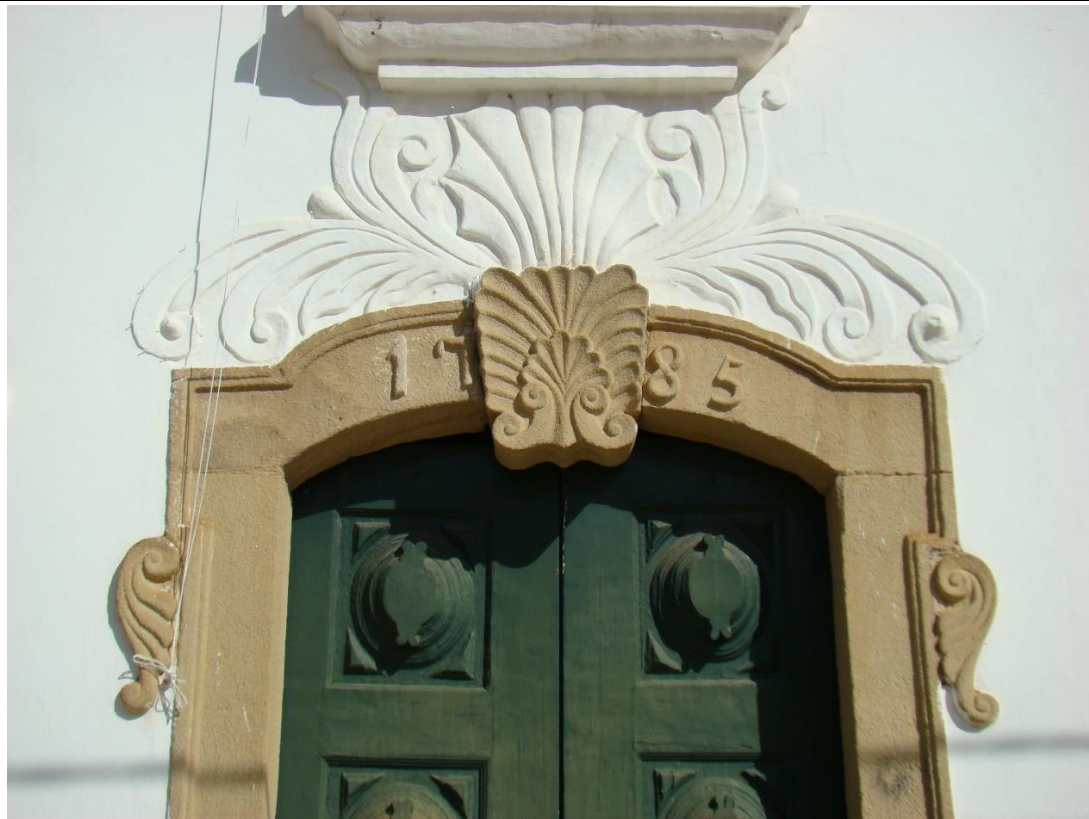
Figura 354 – Detalhe da portada da igreja matriz de Nossa Senhora da Expectação de Icó.
