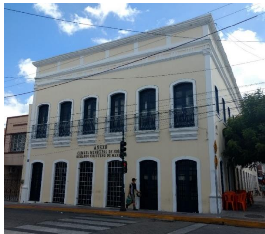
Foto 57: Anexo da Câmara Municipal de Sobral. 2018. Foto: Marcelly Barreira
