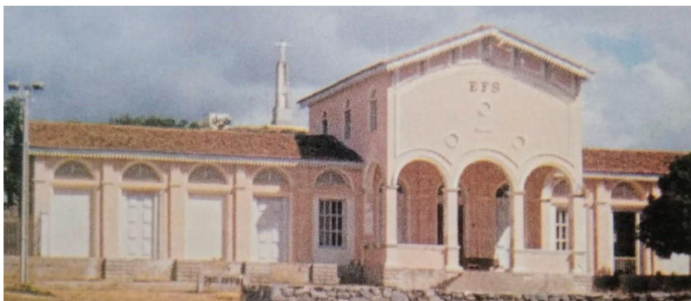
Foto 05: Estação Ferroviária de Sobral. Fonte: Herbert Rocha
