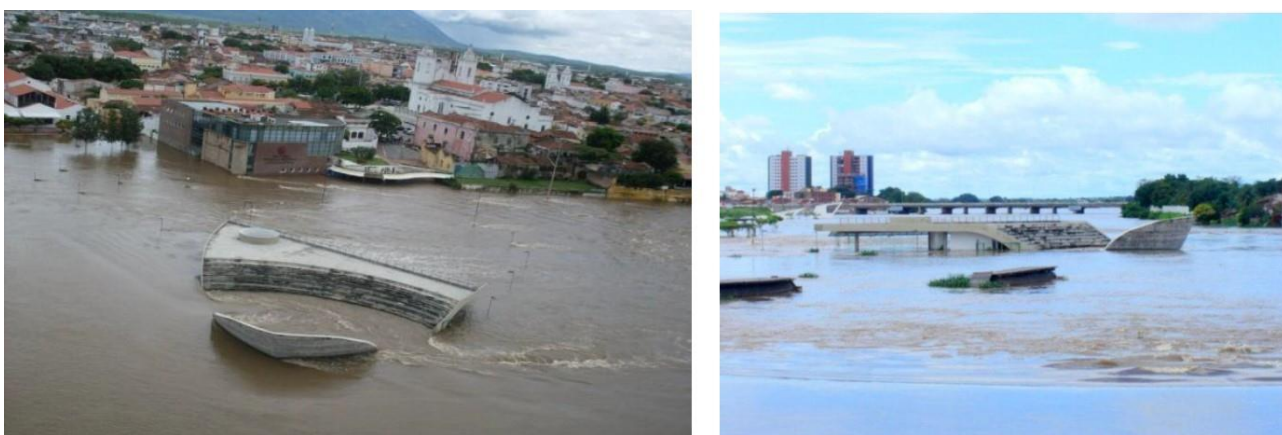
Fotos 43 e 44: Enchente na Margem Esquerda em Sobral/Ce.
