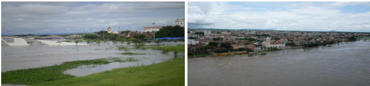
Fotos 41 e 42: Enchente na Margem Esquerda em Sobral/Ce.
