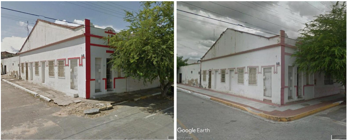
Fotos 26 e 27: Passeios do centro histórico de Sobral antes e depois da requalificação dos passeios Esquina das ruas Dr. Monte com Oriano Mendes. Centro - Sobral/Ce. Fonte: Google Earth
