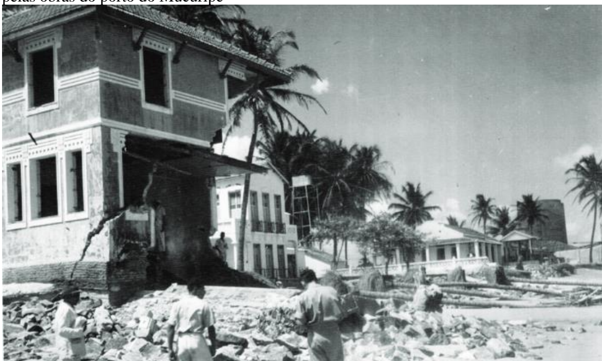
Figura 10 – Bangalôs da Praia de Iracema destruídos pelo avanço do mar causado pelas obras do porto do Mucuripe
