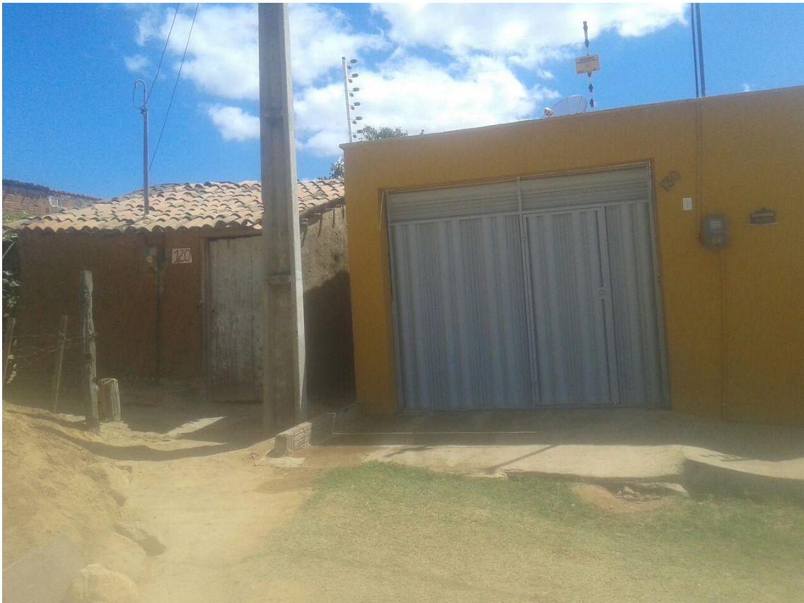
Imagem 04 - Casa voltada para faixa 2 do PMCMV, ao lado de casa de taipa no bairro Muriti, Crato
