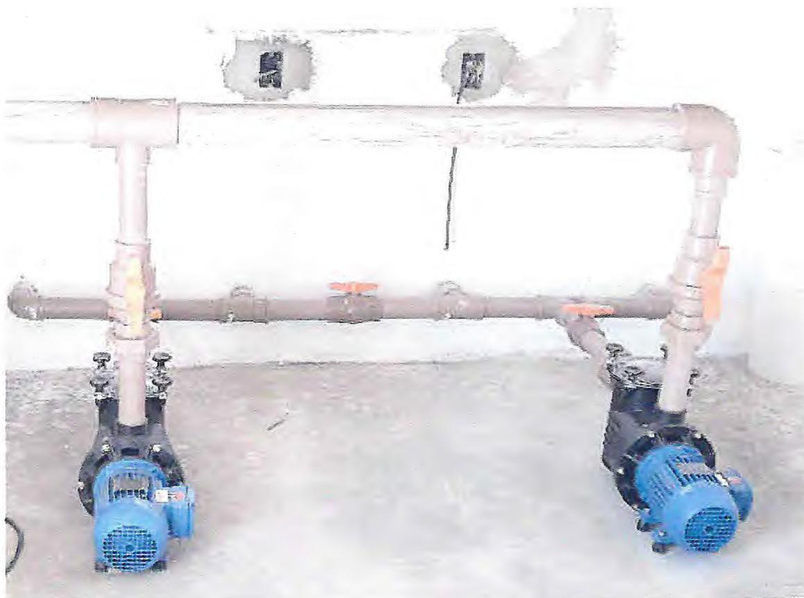
**figura 7-** detalhe das instalações de duas eletrobombas tipo “jakusa” que bombeiam água do canal de abastecimento da fazenda para a caixa filtro.
