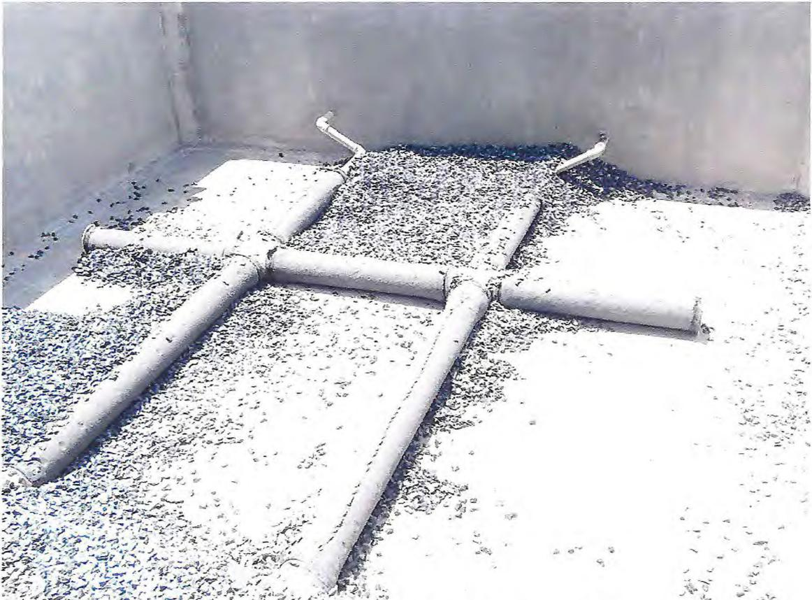
**figura 5- detalhe do material filtrante da caixa filtro, onde se observa: tubulação coberta por brita recebendo a camada de areia grossa e em seguida uma de areia fina.**
