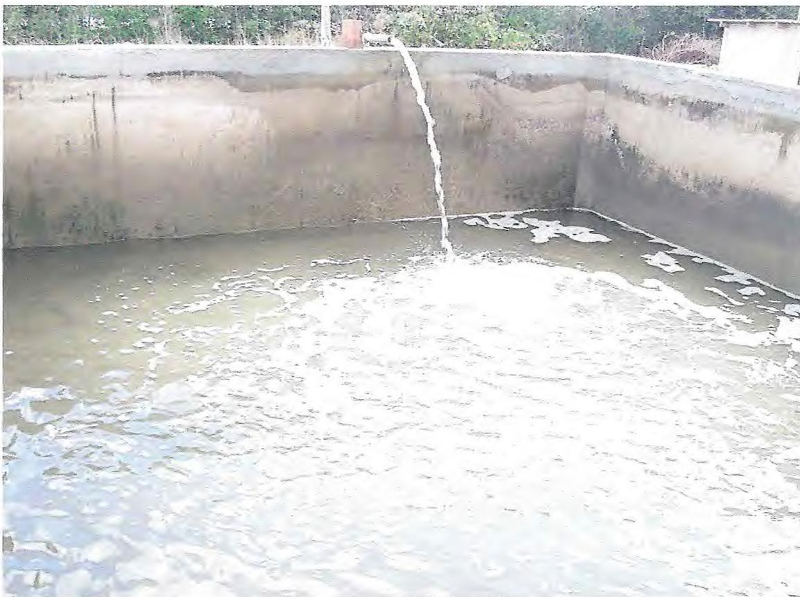
**figura 6- filtro mecânico e biológico em funcionamento, água passando primeiro pela camada de areia fina em seguida pela grossa e logo depois pela brita, então é filtrada pela malha de bidin.**
