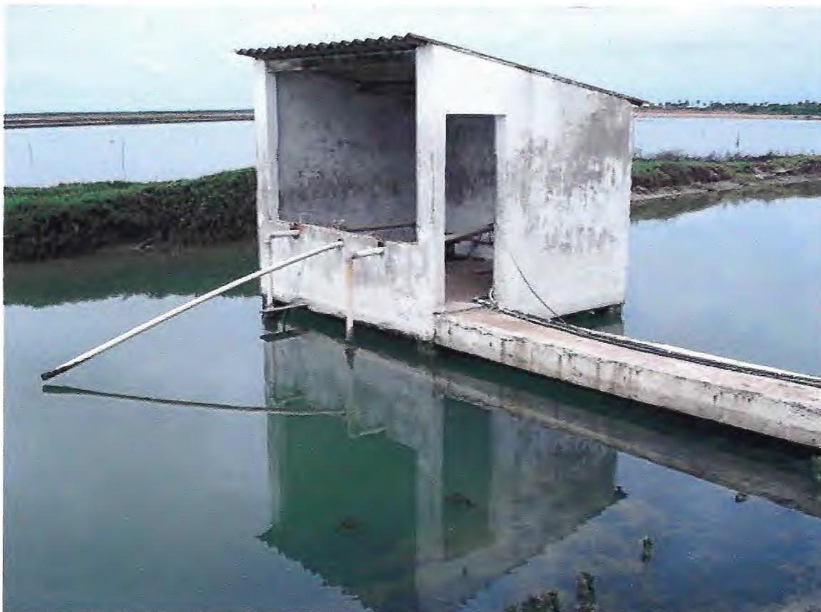
**figura 4 - casa de bomba para adução da água do canal para a caixa filtro (composta por duas eletrobombas tipo jakusa).**
