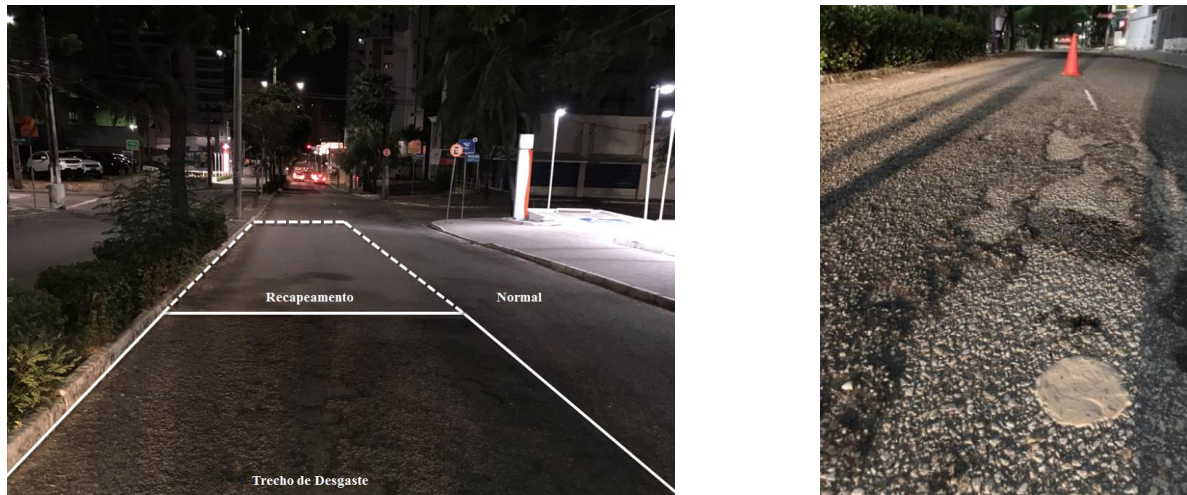
Figura 11 – Estados de conservação do pavimento considerados e detalhe do desgaste observado em campo
