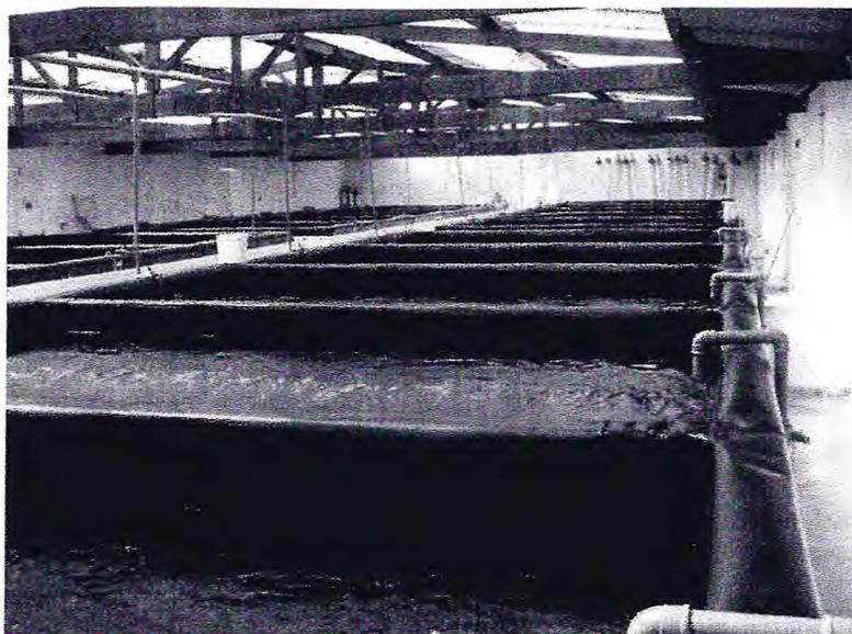
FIGURA 8 – Detalhe de tanques de larvicultura (Fase I) em ambiente fechado propostos para o empreendimento.
