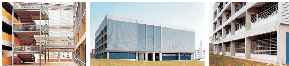
Imagem 22 - rua interna; fachada com “guelras”; vista lateral Fonte: http://www.arcoweb.com.br/
