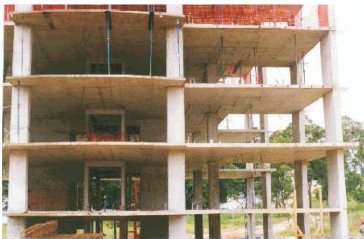
Imagem 28: Edifício residencial sem vigas
