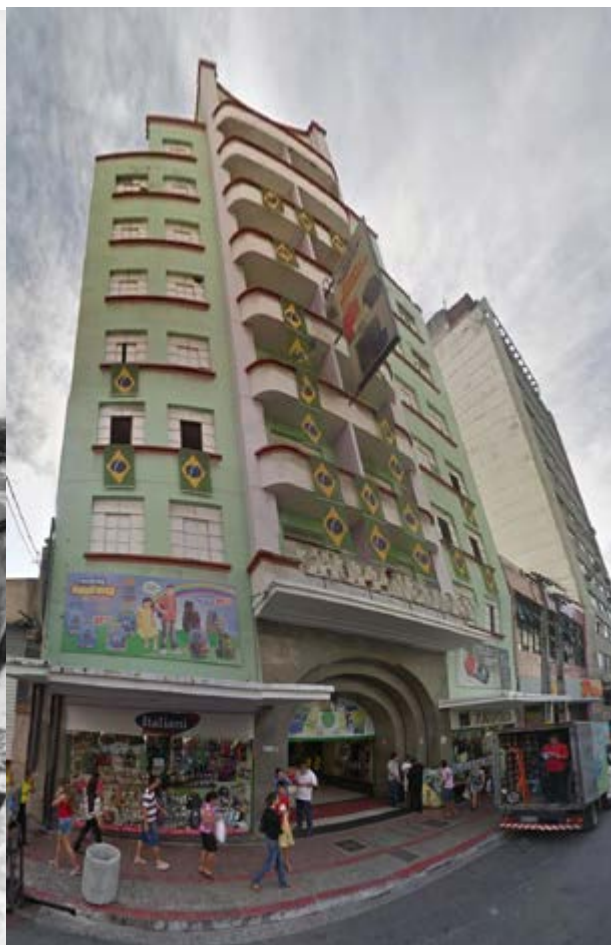
Figura 14. Vista do Edifício Diogo em 2013, durante a Copa do Mundo. Retirado do Google Street View.
