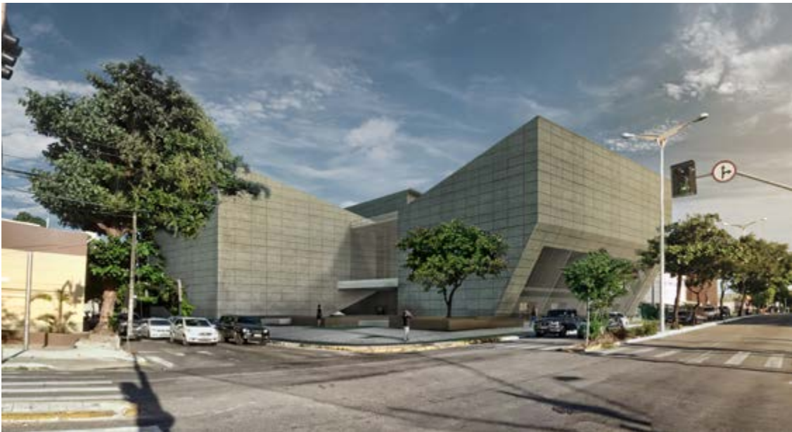
Figura 81. Vista do prédio no cruzamento da Av. Barão de Studar com a R. Júlio Siqueira.
