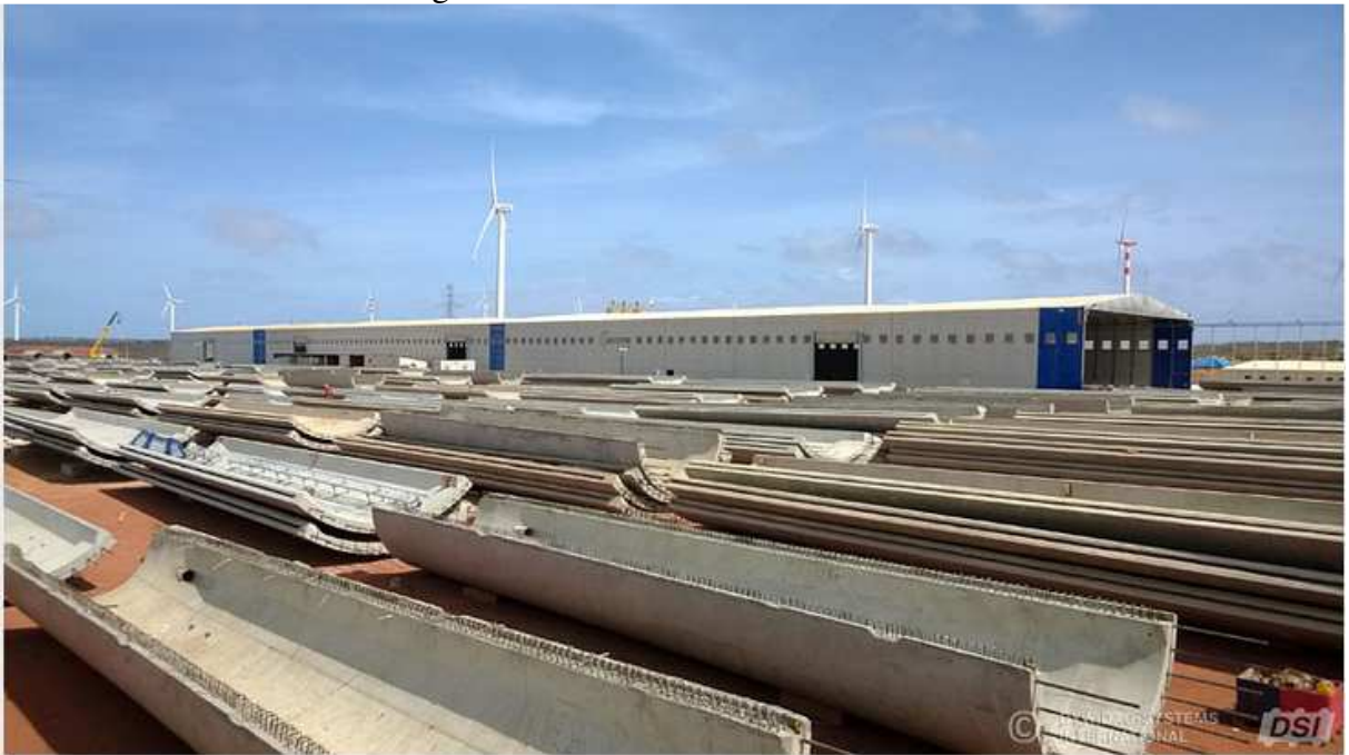
Figura 4 - Painéis curvos de concreto
