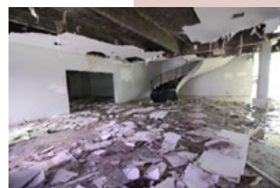
Fig. 285. Aspecto do estado atual do edifício, com a escada helicoidal no interior do bloco A do CCC Fonte: Jornal O Povo, 06/04/2017
