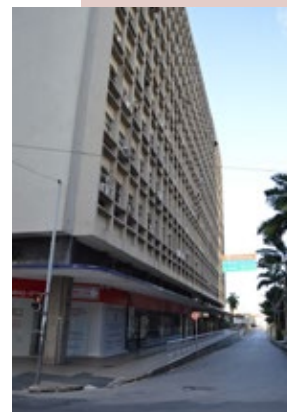
Fig. 75. Elementos horizontais e verticais do edifício Palácio Progresso (1964), José Liberal de Castro Fonte: Acervo fotográfico da autora (2018)
