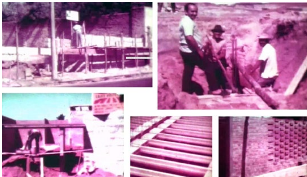
Fig. 250. Imagens da construção em 1970, retiradas do vídeo Fonte: Ivan Gondim (2018)
