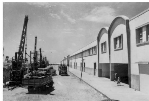
Figura 21: Porto do Mucuripe em construção. Fonte: http://www.fortalezaemfotos.com.br/2014/ . Consulta em 12/11/2017.
