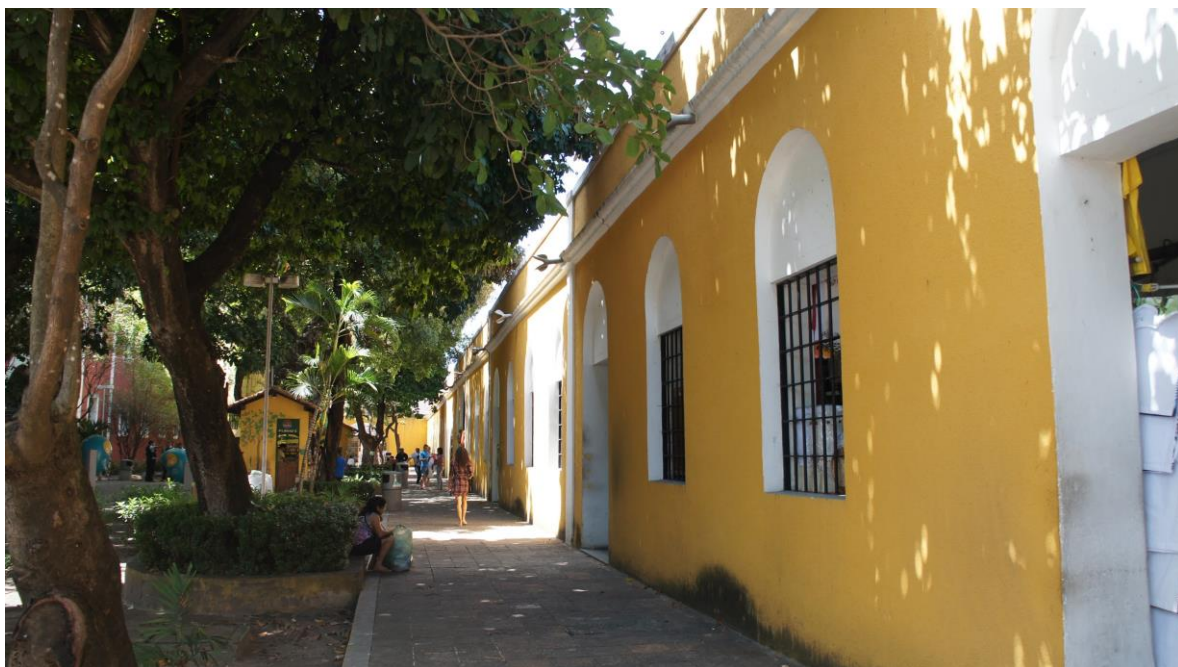
Figura 31 - Área interna (pátio) do prédio da EMCETUR (antiga cadeia).
