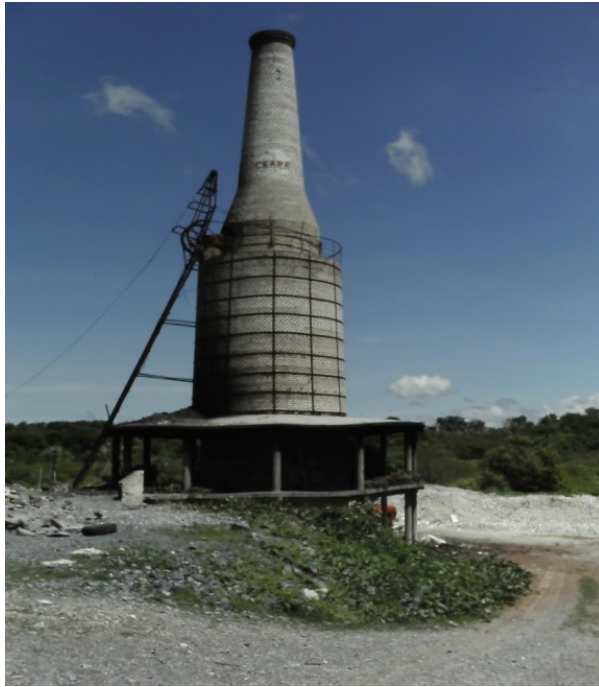
Figura 4 - Forno de cal contínuo localizado em Aroeiras, município de Coreaú.
