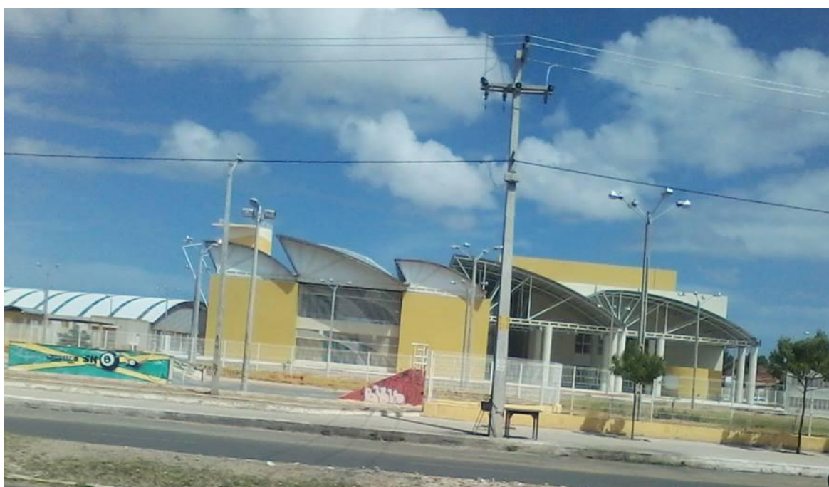
Figura 3 – Cuca do Jangurussu localizado na Avenida Castelo de Castro no São Cristóvão.
