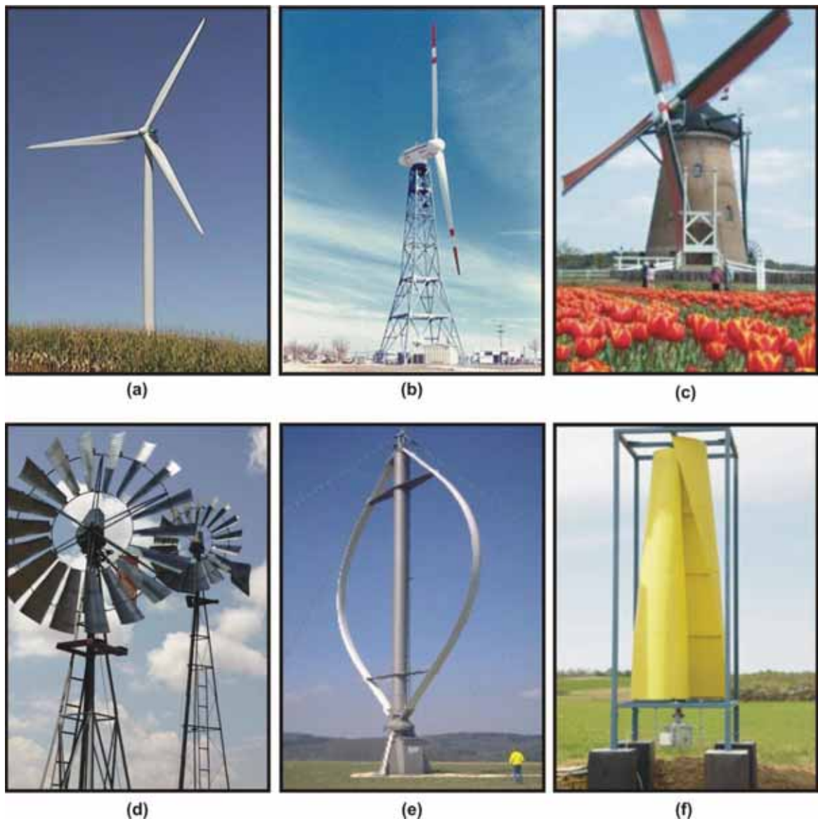
Fig. 1.1 – principais turbinas eólicas utilizadas no mundo: (a) três pás, (b) duas pás, (c) holandesa de quatro pás, (d) multi-pás americana, (e) Darrieus e (f) Savonius.
