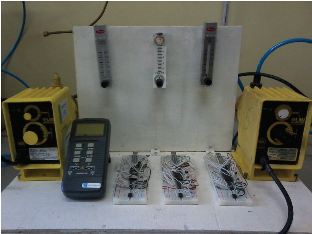
Figura 24: Instrumentos de monitoramento e controle.
