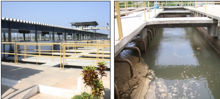
Figura 7 - Fotografia do filtro de areia descendente nº16 em operação na ETA Gavião.
