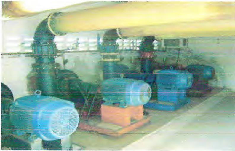
**Figura 6** – Visão de 4 eletrobombas usadas para a captação da água e armazenamento no canal de abastecimento.
