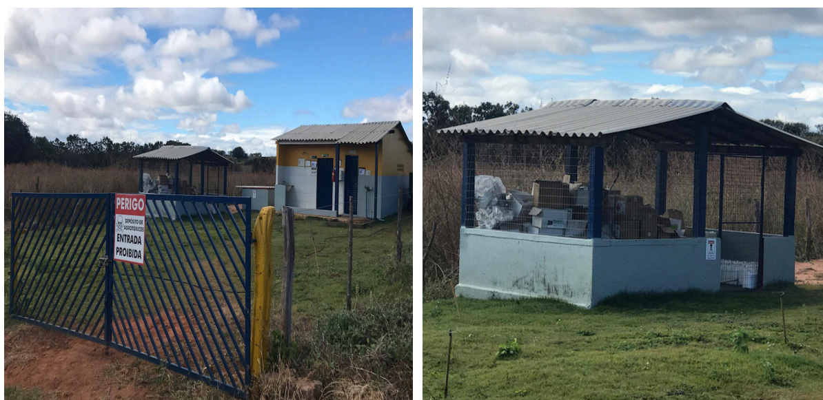
Figura 43 – Galpão de armazenamento de embalagens vazias de agrotóxicos - Morada Nova, Ceará.
