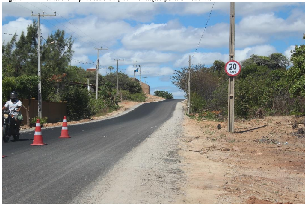
Figura 11 – Estrada em processo de pavimentação para a Reserva
