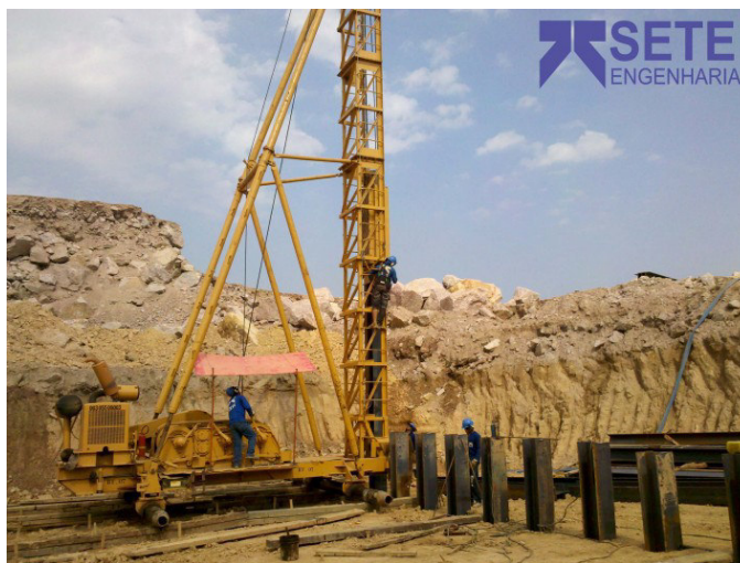
Figura 27 – Processo de cravação dos perfis
