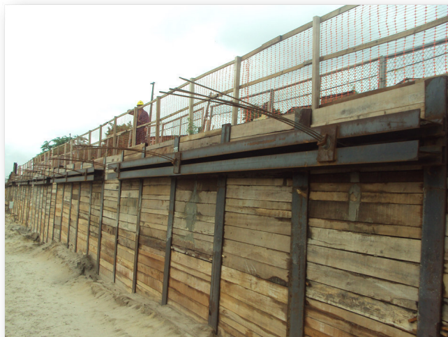
Figura 25 – Cortina com perfis pranchados
