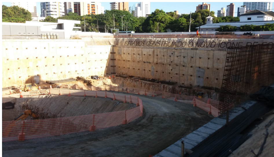
Figura 56 – Parede diafragma do BS Design finalizada
