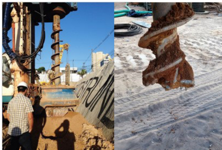
Figura 46 – Equipamento de pré-furo
