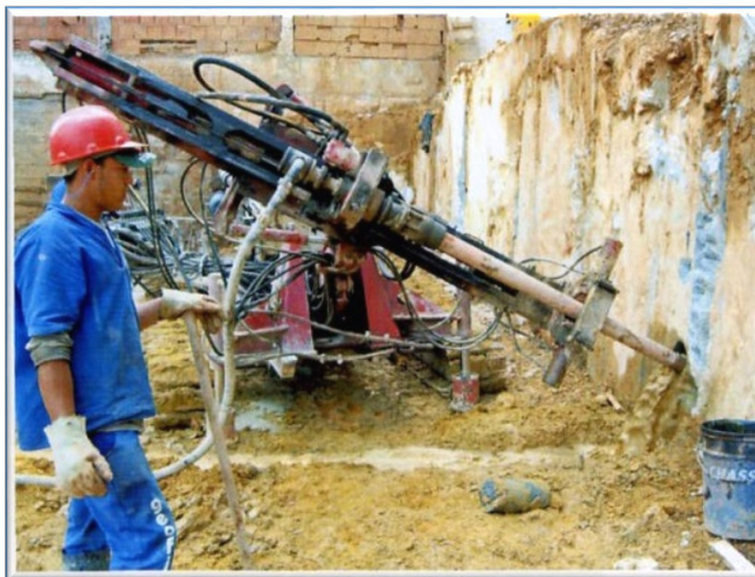
Figura 52 – Perfuração para colocação do tirante
