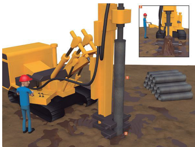
Figura 13 – Perfuratriz e elementos tubulares
