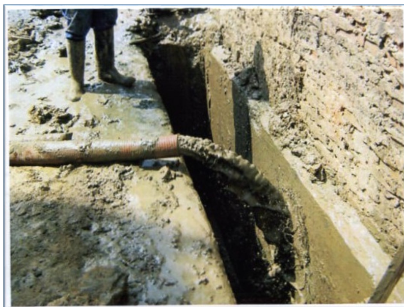
Figura 48 – Lançamento da bentonita
