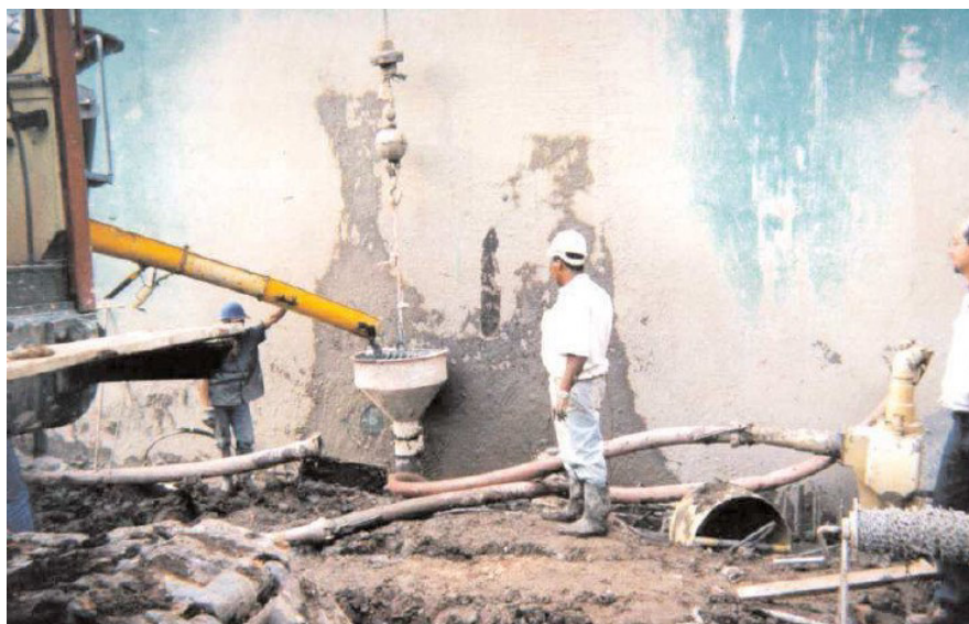
Figura 39 – Lançamento de concreto
