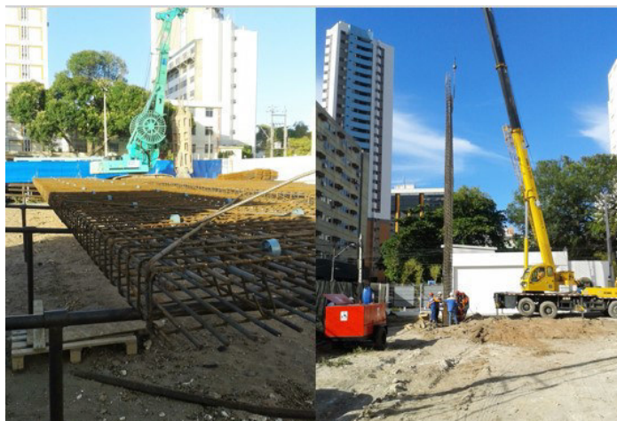
Figura 49 – Armação e colocação da armadura no local
