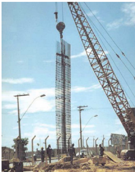
Figura 38 – Colocação da armadura
