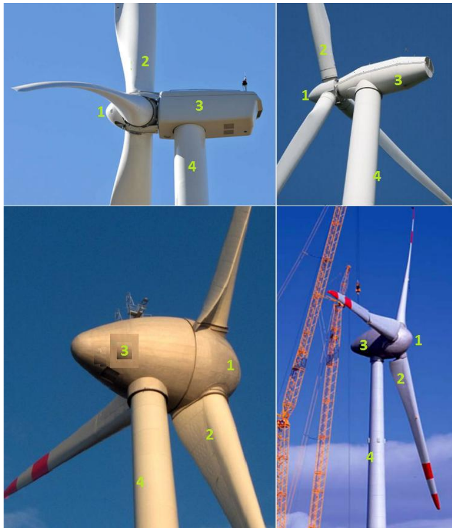
Figura 18 – Partes principais de um aerogerador em funcionamento.
