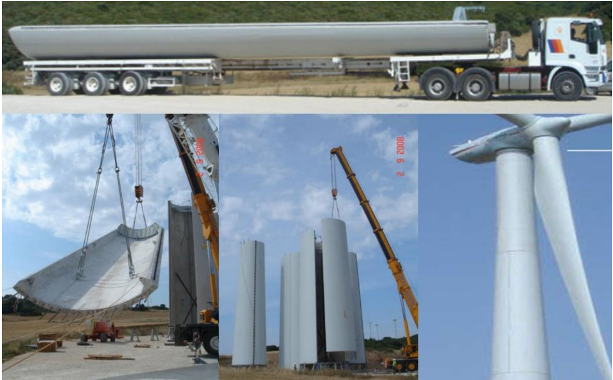
Figura 20 – Torre de concreto armado pré-fabricada com proteção de patente, altura de 100 m e diâmetro da base superior a 7 m. Parque eólico de Peñablanca, Toledo (Espanha). Fonte: Inneo,2009.
