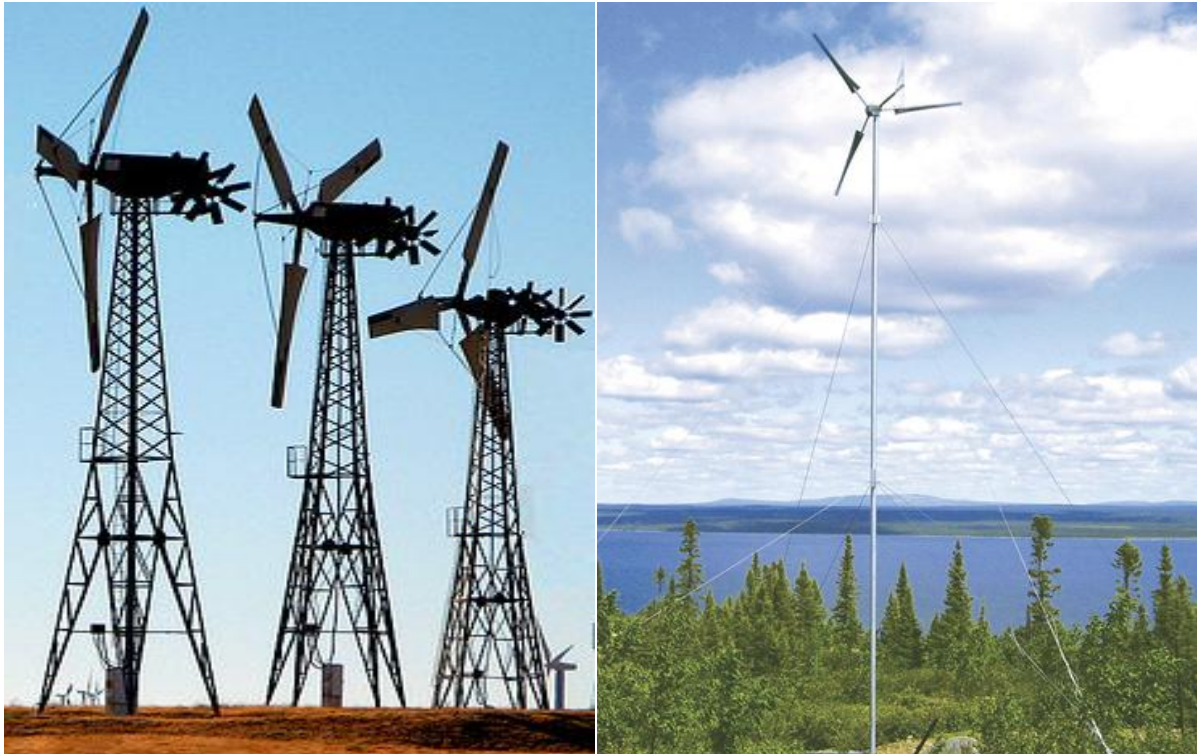
(a) – Torre tipo treliça.
