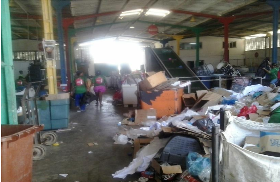
Figura 14 – Parte central da usina de reciclagem
